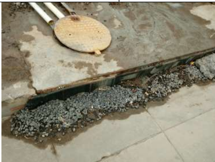
Fotografía No. 11: Se observa alcantarillado con grava y malla para atrapar los sedimentos. Fuente: Grupo ITS.
