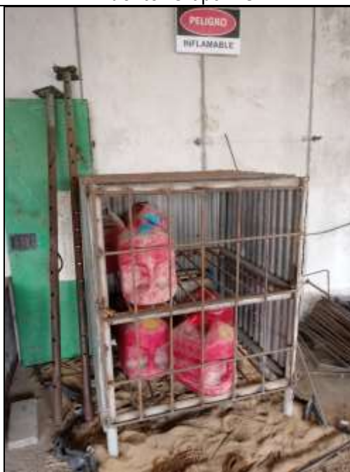
Fotografía No. 7: Lugar de almacenamiento de combustible con su noria de contención. Fuente: Grupo ITS.
