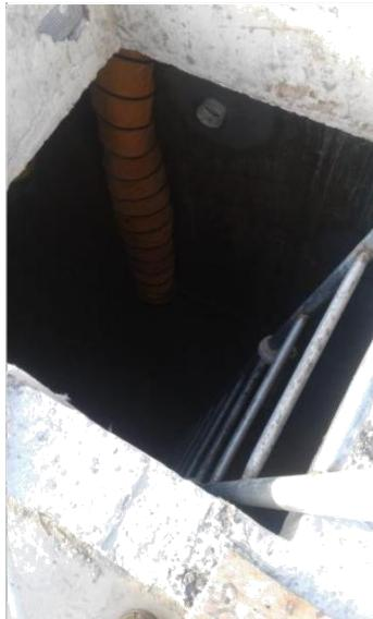
Cumpliendo con la respectiva medición de gases, en espacio confinados. Durante la impermeabilización del tanque de agua torre BC.
