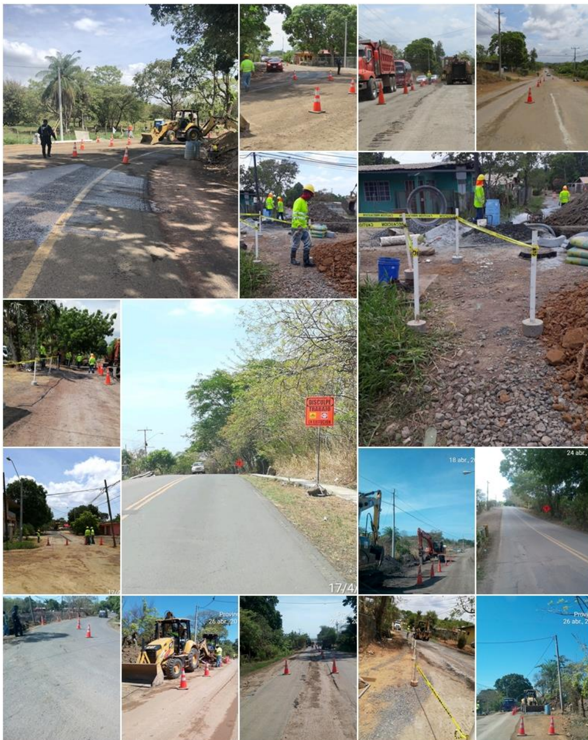
Foto 6. COLOCACIÓN DE SEÑALIZACIÓN E INSTALACION DE PASOS PEATONALES EN LAS ÁREAS DE TRABAJO.
