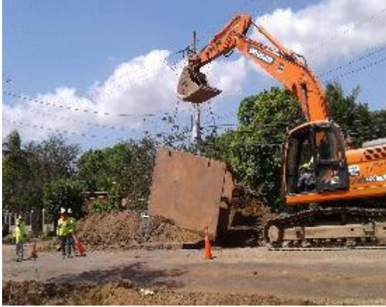
Control de ingeniería: Uso de Entibados metálicos en excavaciones
