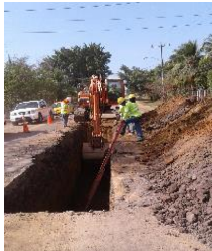
Uso de escaleras y retiro de material del borde de la excavación
