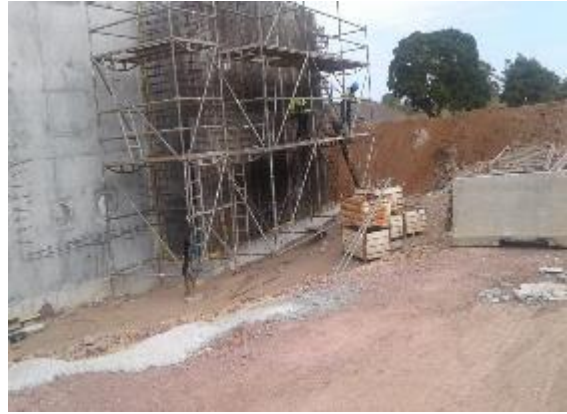
PTAR: Uso de andamios y elementos de sujeción (arnes-linea de vida)
