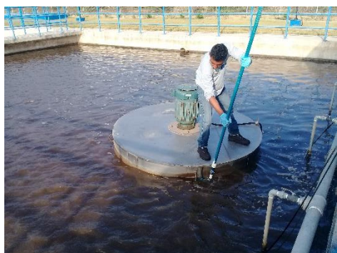
Limpieza del mezclador
