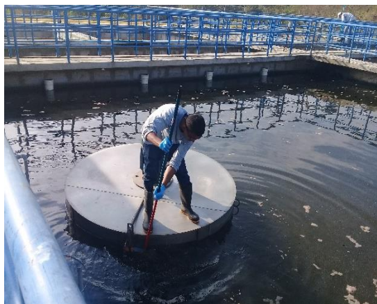
Limpieza del mezclador
