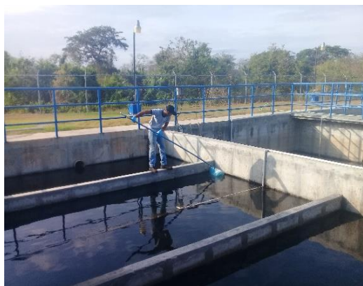
Limpieza de la cámara de cloración
