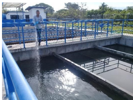
Limpieza de la cámara de cloración
