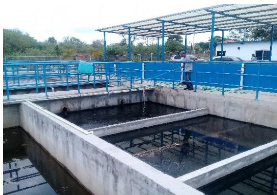
Limpieza de la cámara de cloración
