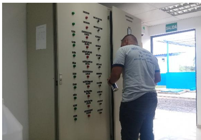
Limpieza del tablero de control.
