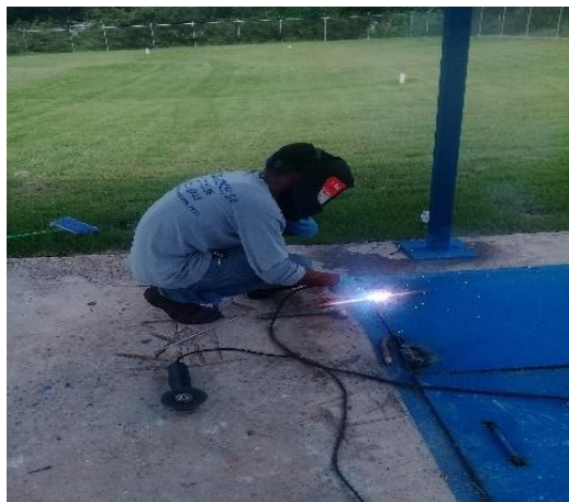
Reparación de las bisagras
