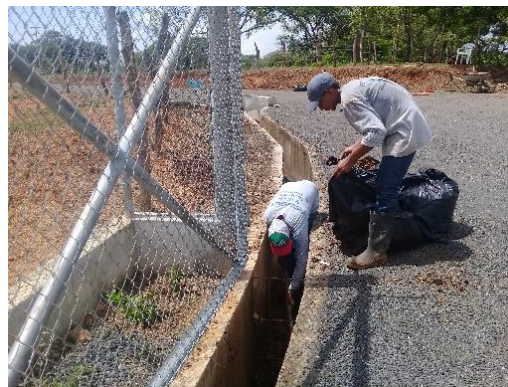
Limpieza de los canales de agua pluvial de la PTAR
