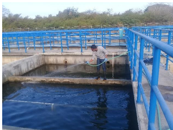
Limpieza de la cámara de cloración
