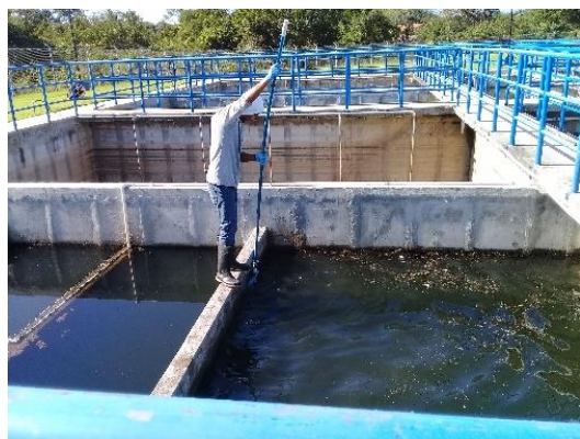
Limpieza de la cámara de cloración
