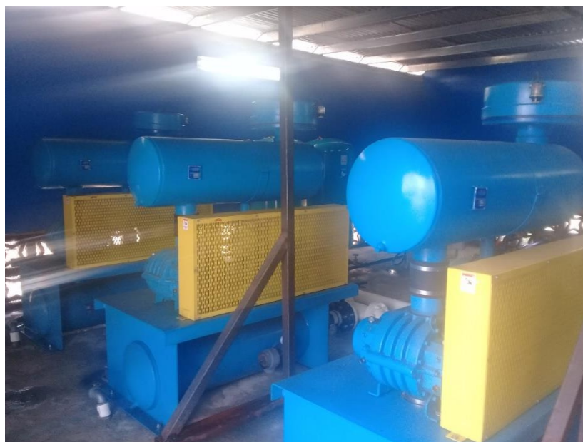
Limpieza de filtros de los sopladores
