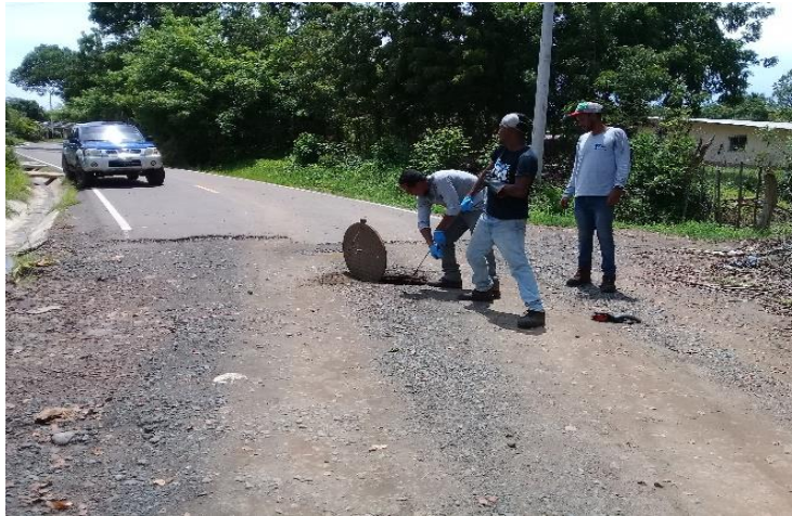
Destape de una obstrucción en el CI de la entrada que va al foso de bombeo
