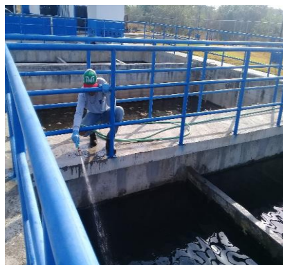
Limpieza de la cámara de cloración
