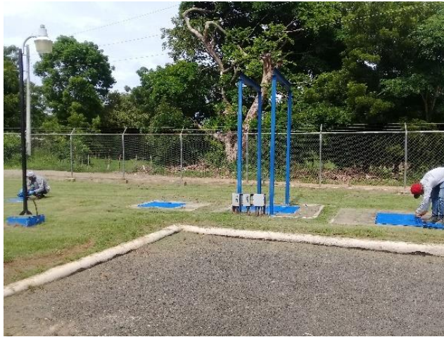
Colocación de pintura de las estructuras metálicas
