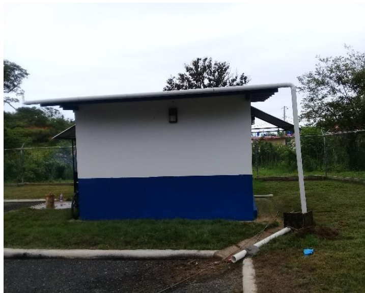
Se colocó un caño para el drenaje de las aguas pluviales.
