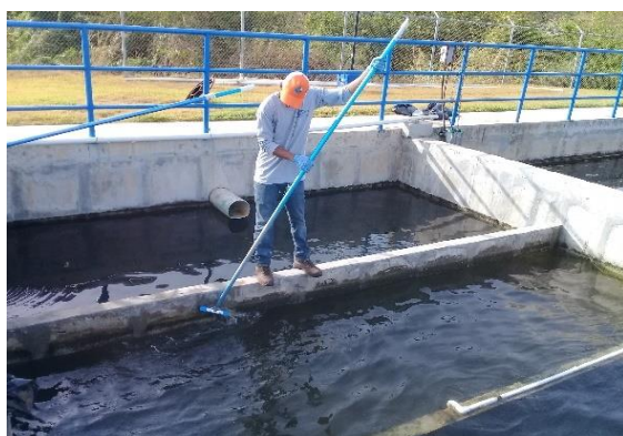
Limpieza de la cámara de cloración
