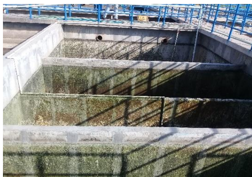
Extracción de lodo de la cámara de cloración
