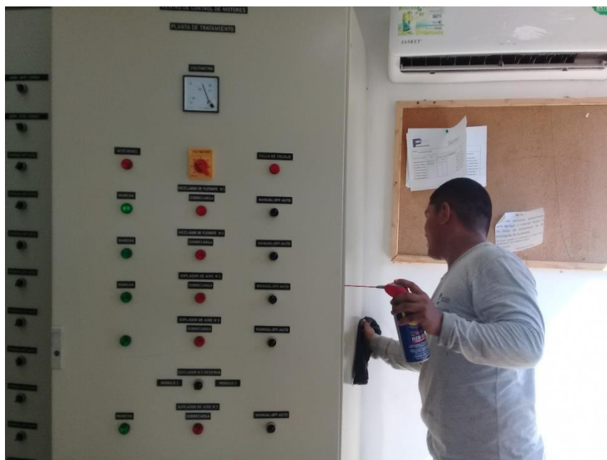
Limpieza de tablero de control
