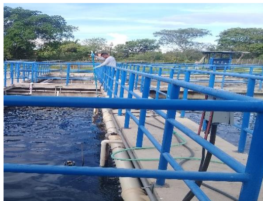
Limpieza de los canales de agua pluvial de la PTAR
