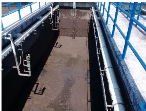
Limpieza de sedimentadores.
