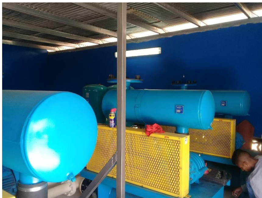
Limpieza de sopladores de aire
