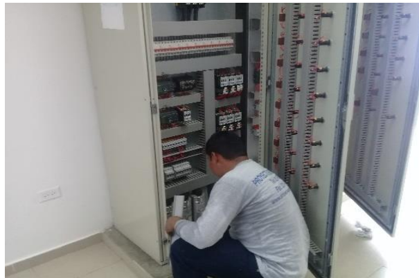
Limpieza de tablero de control
