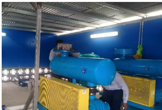
Limpieza de filtro de sopladores
