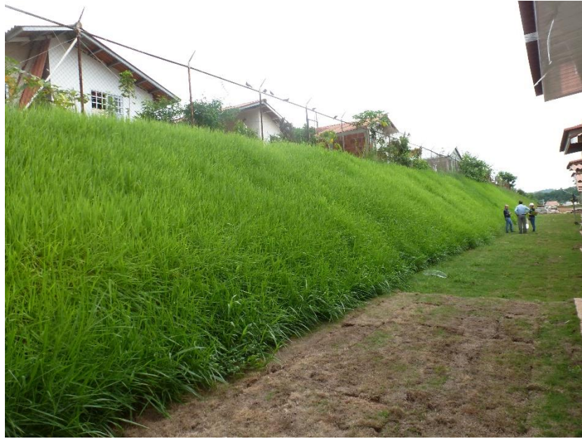
VISTA DE LA SIEMBRA DE GRAMINÉA EN TALUDES
