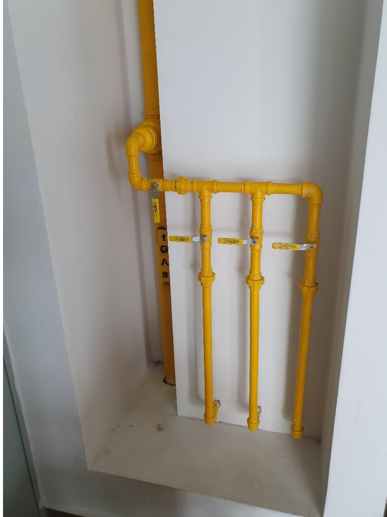
Foto N° A1-19. Tubería de gas señalizada.
