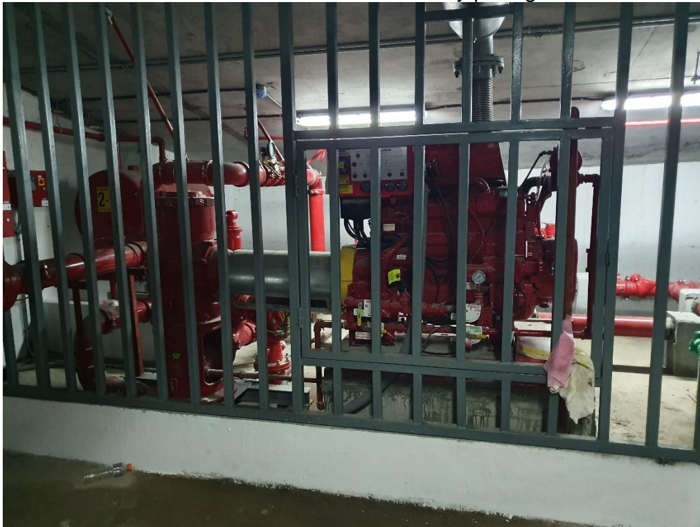
Foto N° A1-23. Bombas de alta presión para agua.
