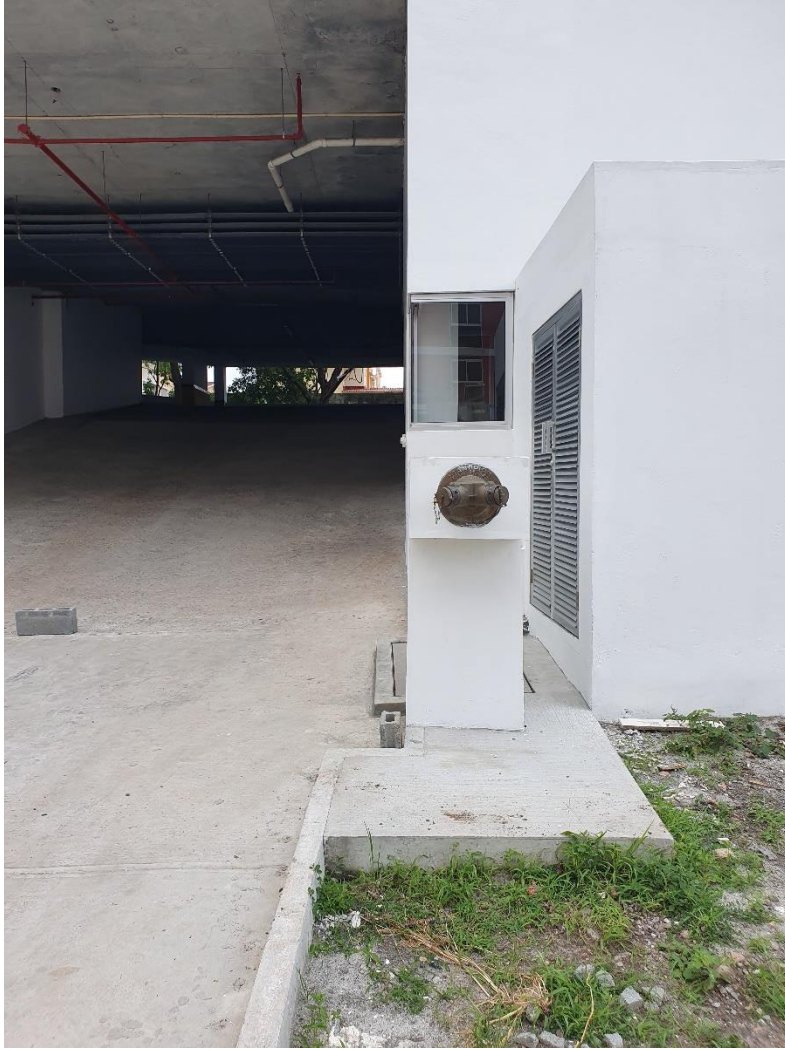
Foto N° A1-19. Toma de agua para Bomberos en caso de emergencia.
