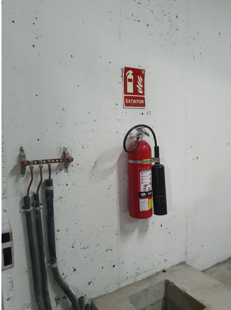
Foto N° A1-21. Extintor especial según área a artender.
