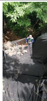
Foto 32) Estabilización del deslizamiento en el talud sur del aeropuerto
