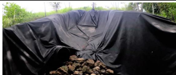
Foto 30) Estabilización del deslizamiento en el talud sur del aeropuerto
