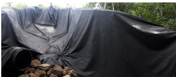
Foto 31) Estabilización del deslizamiento en el talud sur del aeropuerto
