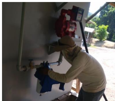
Foto 2) Mantenimiento de la suplidora de combustible del campamento
