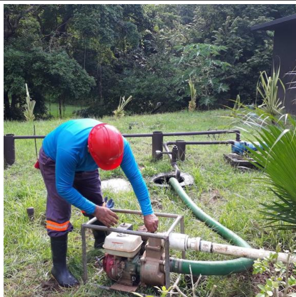
Foto 34) Extracción del agua tratada por la PTAR para irrigación
