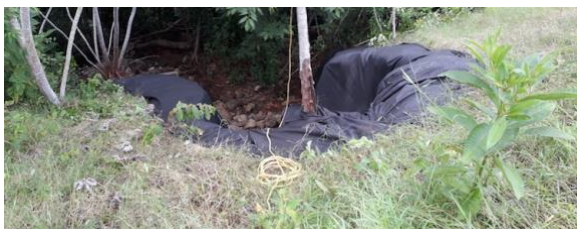
Foto 29) Estabilización del deslizamiento en el talud sur del aeropuerto
