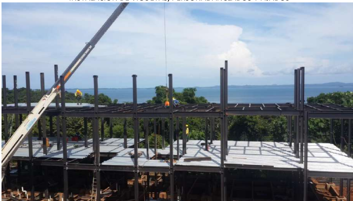
INSTALACION DE VIGUETAS, PERSONAL ANCLADOS Y FIJADOS
