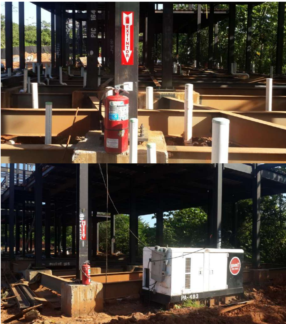
Colocación de extintores en áreas señalizadas
