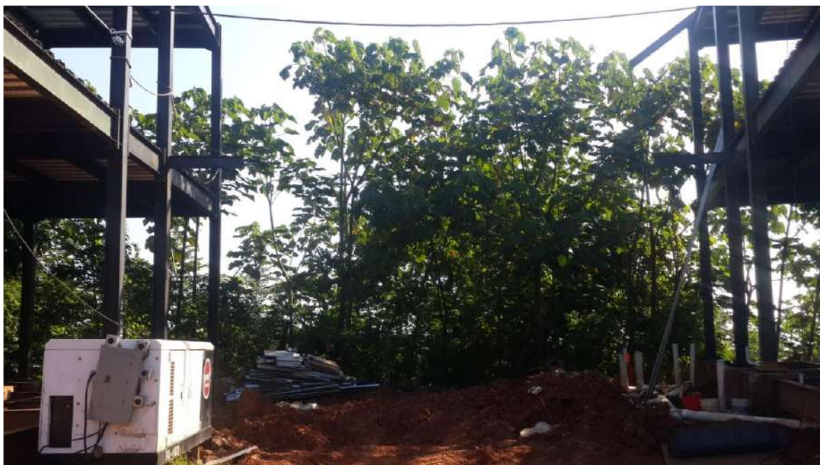
Se elevan los cables y se cubre el panel eléctrico
