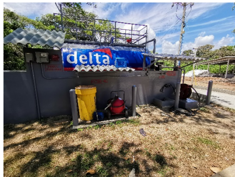
Foto 4) Extintor y kit antiderrames en la estación de combustible
