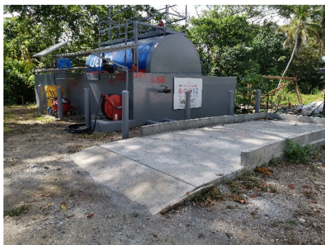
Foto 3) Estación de combustible señalizada y con piso de concreto
