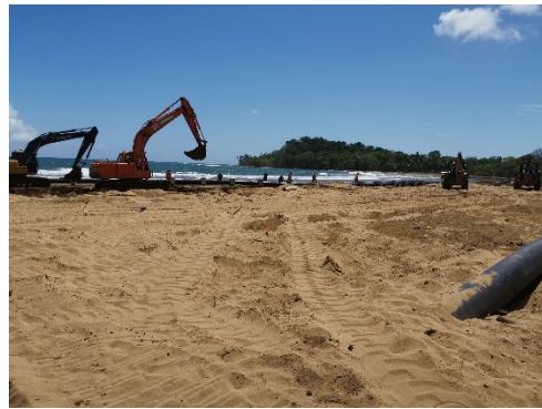
Foto 20) Equipo laborando en la instalación de los puntos de anclaje de la tubería
