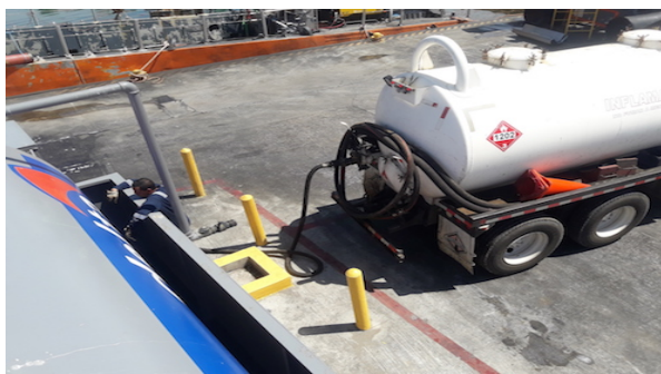
Foto 6) Extracción de agua de la noria del tanque diesel por parte de personal calificado
