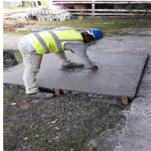
Fotografías No. 47 Vaciado de concreto de aro y tapa de tráfico pesado de la caja.
