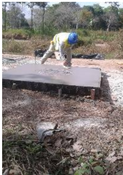
Fotografías No. 31 Tapa de concreto finalizada.
