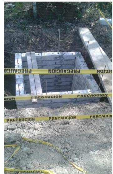
Fotografías No. 32 Bloqueo de pared de bloques Lincon
