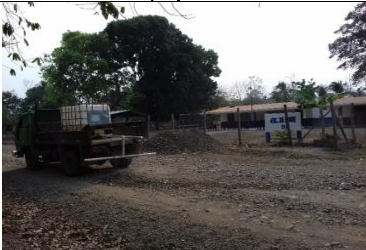
Fotografías No. 6 Camión pequeño para regar agua en el camino, para controlar polvo •Evidencias mantener la humedad dentro de la zona donde se estén realizando obras del proyecto
