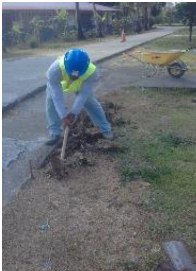
Fotografías No. 44 Excavación manual de la caja de Interconexión 3.
