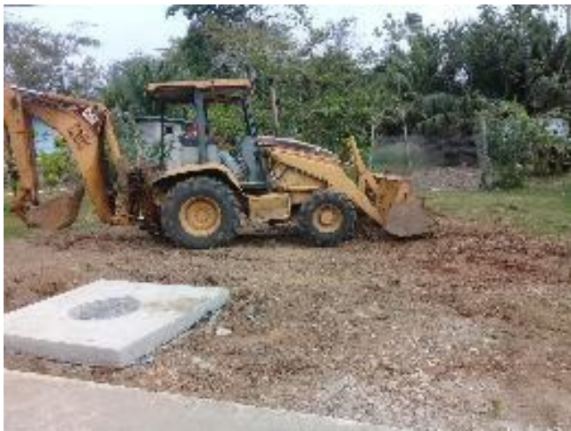
Fotografías No. 41 Colocación de la tapa de concreto con su aro y tapa.
