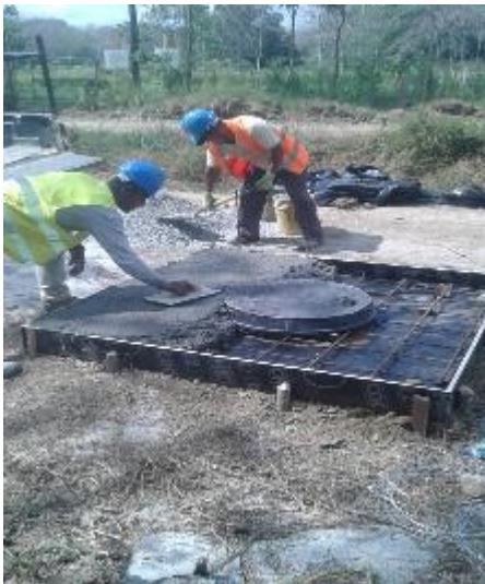
Fotografías No. 30 Vaciado de tapa de concreto reforzado con su aro y tapa de tráfico pesado
