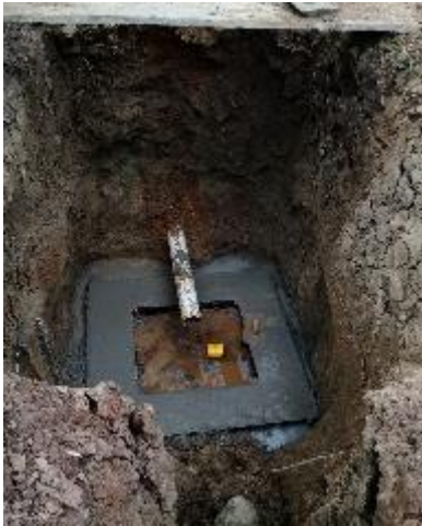
Fotografías No. 29 Construcción de fondo de concreto de la caja de salida de limpieza.
