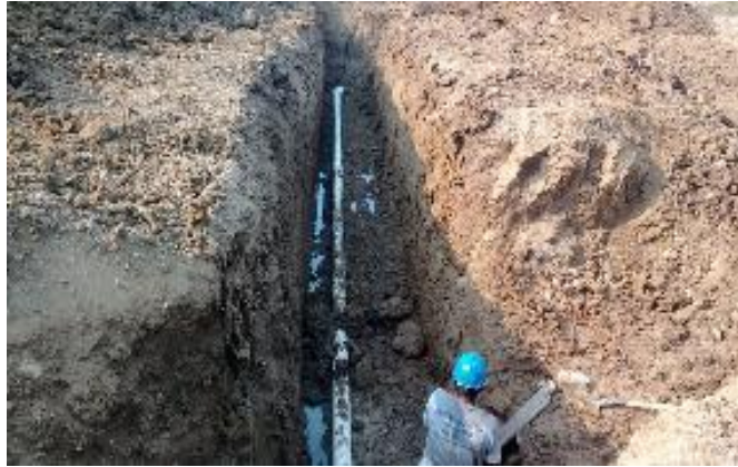
Fotografías No. 19 Trabajos de Instalación de tubería de PVC de 6" hasta cruzar la Quebrada Uruseca.
