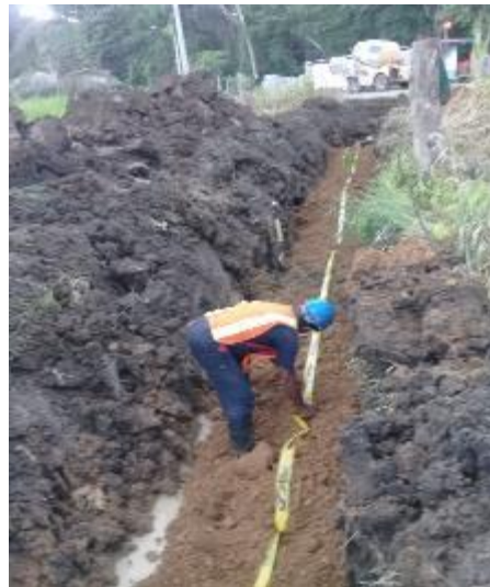
Fotografías No. 27 Colocación de cinta amarilla de precaución para prevenir la rotura de la tubería en futuros mantenimientos.
