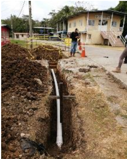
Fotografías No. 42 Instalación de tubería de PVC de 4" hasta la caja de interconexión 3
