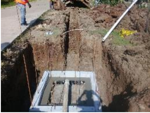
Fotografías No. 39 Colocación de pared de bloques Lincon de Caja y colocación de acero vertical.
