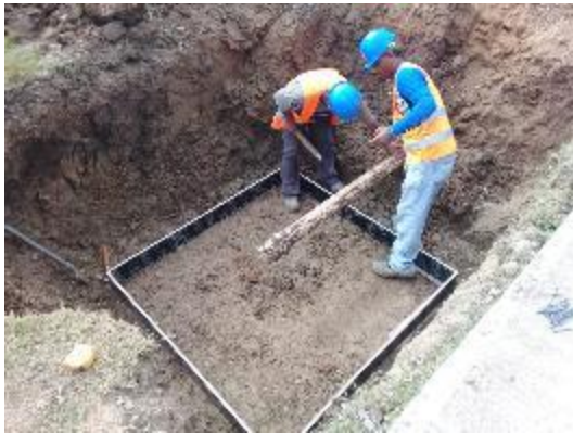
Fotografías No. 36 Colocación de fondo de concreto de caja de interconexión 2.
