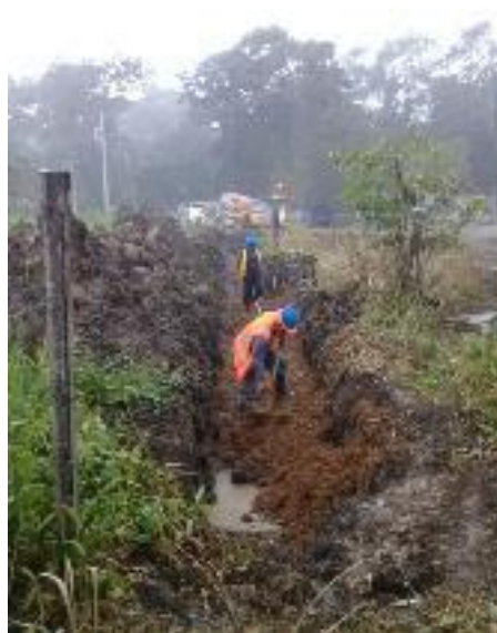
Fotografías No. 28 Colocación de final de material de relleno en toda la tubería de PVC de 4".
