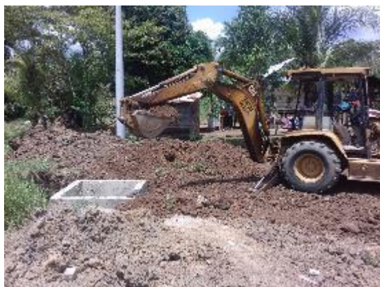
Fotografías No. 35 Relleno de la caja con material de relleno.
