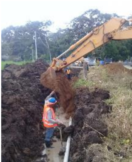
Fotografías No. 26 Colocación de material de relleno de la tubería de PVC
