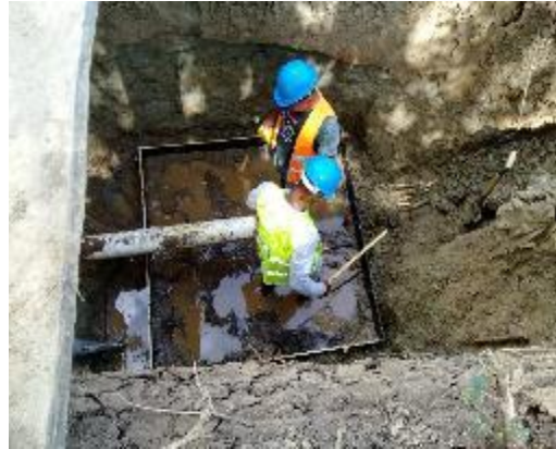
Fotografías No. 29 Construcción de fondo de concreto de la caja de salida de limpieza.
