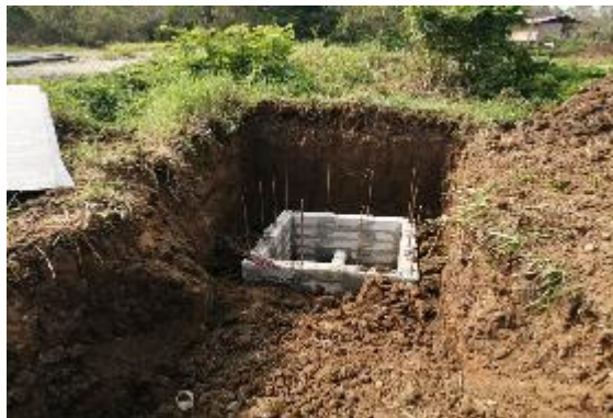
Fotografías No. 34 Bloqueo de caja con bloques Lincon con su colocación de acero vertical.
