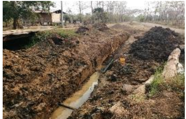
Fotografías No. 18 Trabajos de instalación de tubería de hierro dúctil de 6" en el cruce de la Quebrada Uruseca.
