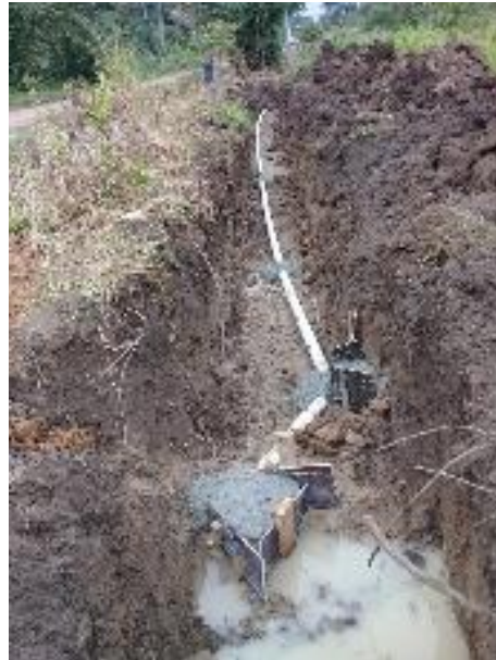
Fotografías No. 23 Colocación de su cuña de concreto en el codo de PVC de 4".
