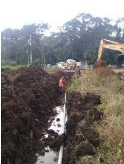
Fotografías No. 24 Instalación de tubería de impulsión de 4" PVC hasta la caja de salida de limpieza de 2".
