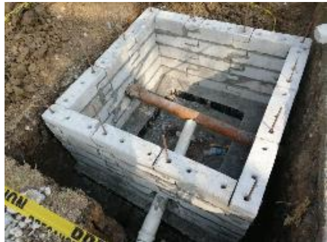
Fotografías No. 49 Colocación de bloques Lincon de la caja e
