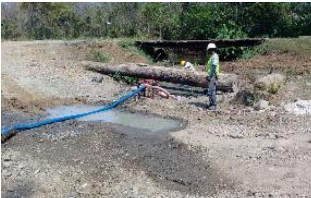
Fotografías No. 17 Trabajos de instalación de bomba de agua para secar la quebrada.
