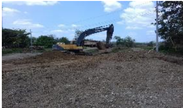
Fotografías No. 21 Trabajos de relleno de la excavación con la pala mecánica.
