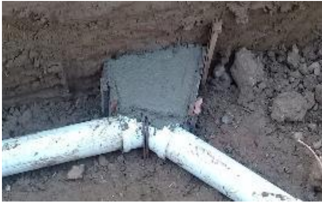
Fotografías No. 20 Instalación de codo de 45x6" y su cuña de concreto de la tubería de 6"
