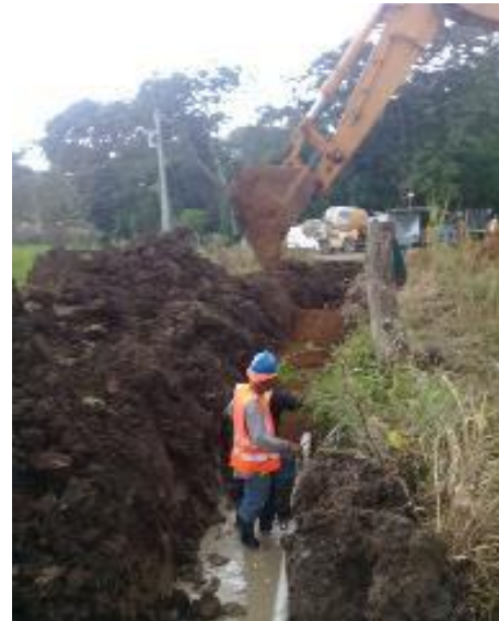
Fotografías No. 25 Colocación de material de relleno de la tubería de PVC de 4"
