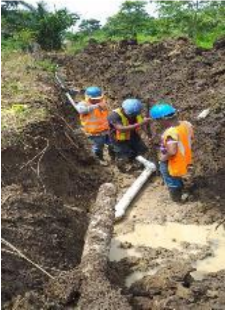
Fotografías No. 22 Instalación de tubería de impulsión de 4" PVC y sus accesorios
