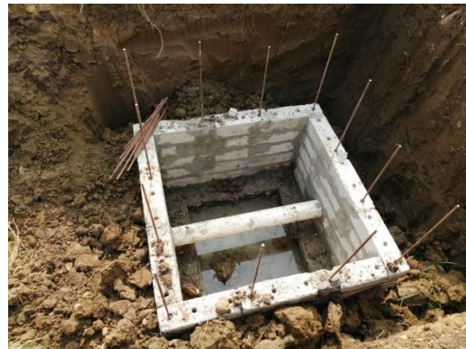
Fotografías No. 34 Bloqueo de caja con bloques Lincon con su colocación de acero vertical.
