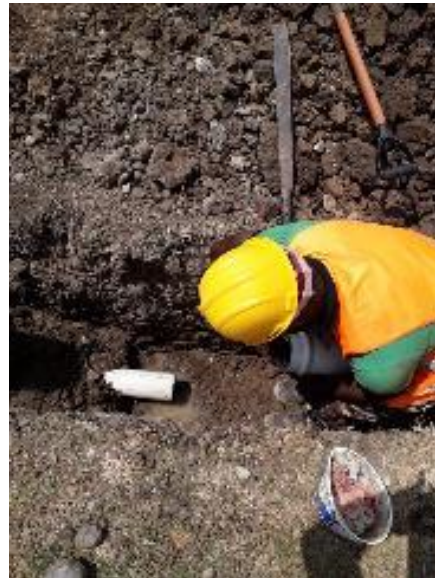
Fotografías No. 43 Instalación de tubería de PVC de 4"
