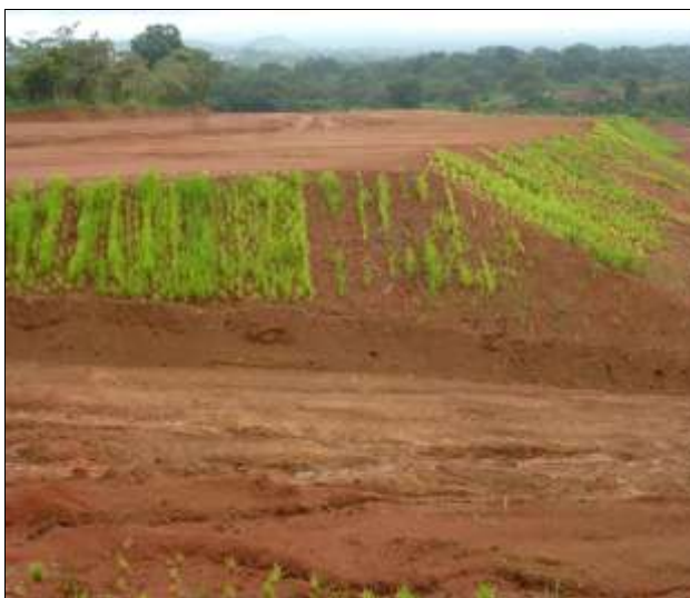
No.5-Revegetación con pasto Brachiarias para el control de Erosión Hídrica
