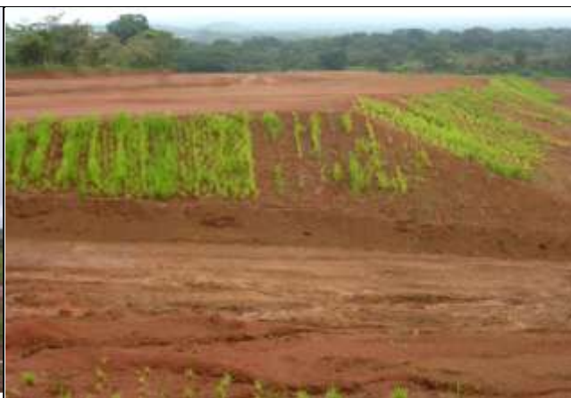
Nº2 Revegetación de taludes, posterior a la lotificación.
