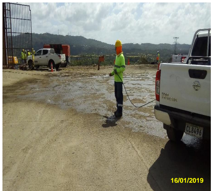
Foto No.1. Medidas adoptadas para controlar la emisión de partículas suspendidas en el aire por acción del viento.
