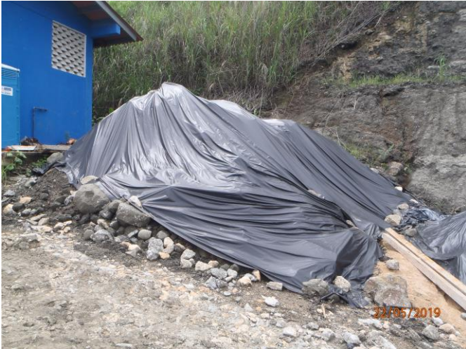
Foto No.5. Cubrimiento del montículos de tierra para evitar generar partículas en suspensión y el aporte de sedimentos a cunetas y drenajes cercanos.
