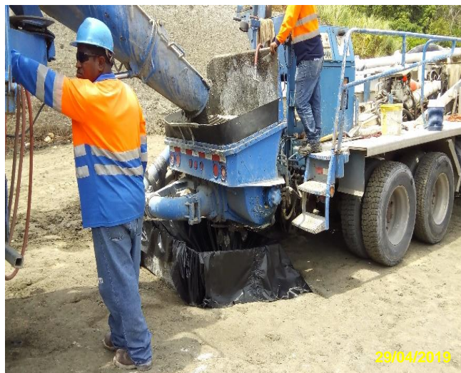
Foto No.13 Tinas móviles para el lavado de las galas. Excavación habilitada para el manejo del concreto residual.
