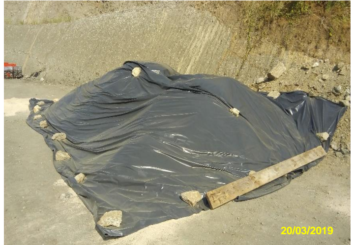
Foto No.5. Cubrimiento del montículos de tierra para evitar generar partículas en suspensión y el aporte de sedimentos a cunetas y drenajes cercanos.
