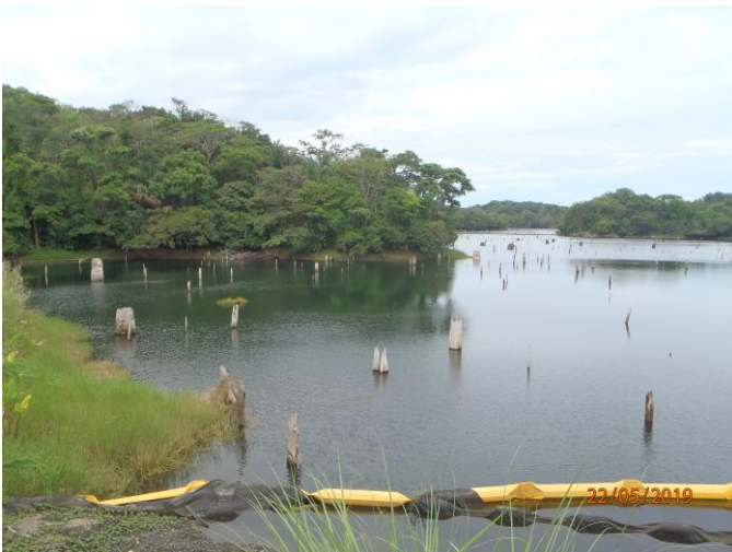
Foto No.6. Barrera flotante para controlar aporte de sedimentos/derrames de hidrocarburos y geotextil no tejido 4000 como refuerzo para atrapar sedimentos en el área de la construcción de la nueva toma de agua.
