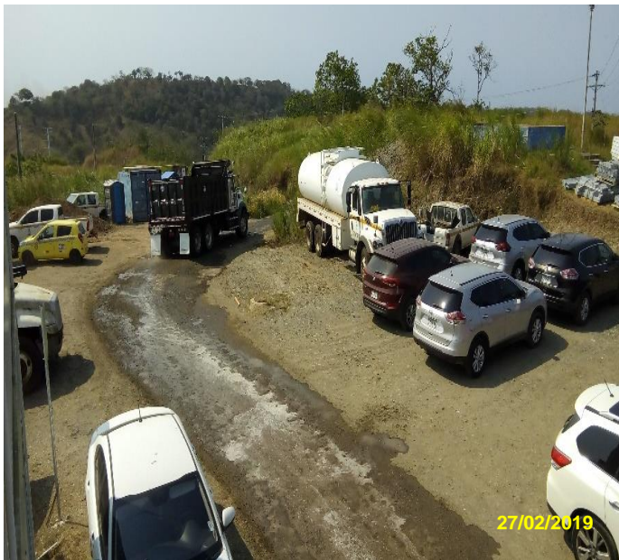
Foto No.1. Medidas adoptadas para controlar la emisión de partículas suspendidas en el aire por acción del viento.
