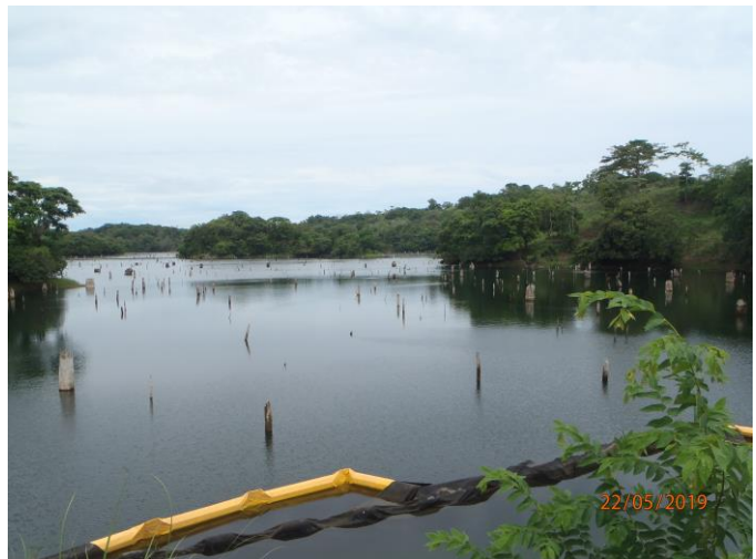
Foto No.6. Barrera flotante para controlar aporte de sedimentos/derrames de hidrocarburos y geotextil no tejido 4000 como refuerzo para atrapar sedimentos en el área de la construcción de la nueva toma de agua.
