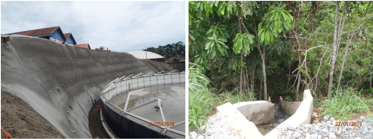
Foto No.8. Medidas implementadas para la canalización y transporte de flujo reduciendo el arrastre de sedimentos.
