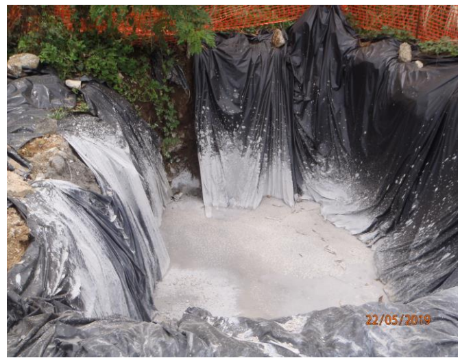
Foto No.13 Tinas móviles para el lavado de las galas. Excavación habilitada para el manejo del concreto residual.
