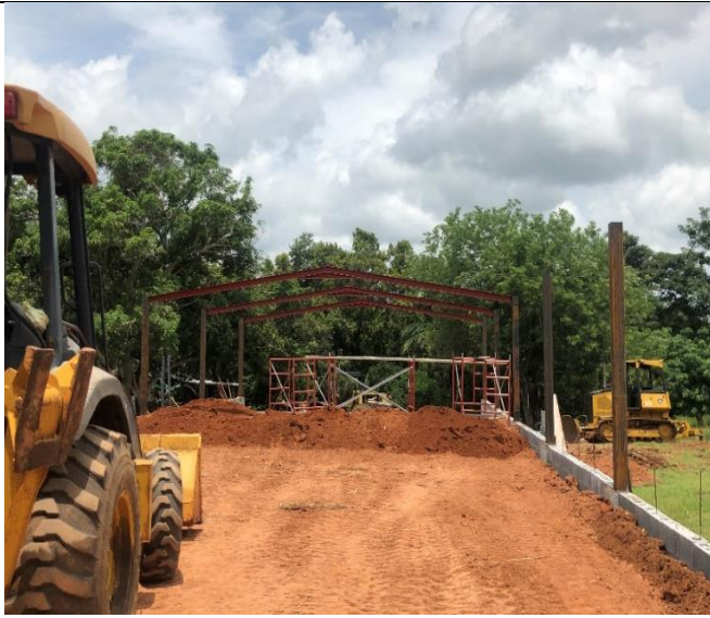
Nivelación de terreno para iniciar con vaciado de piso
