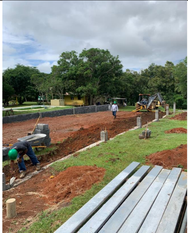
Limpieza de los cimientos e inicio de construcción de las columnas
