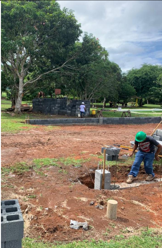
Construcción de las bases
