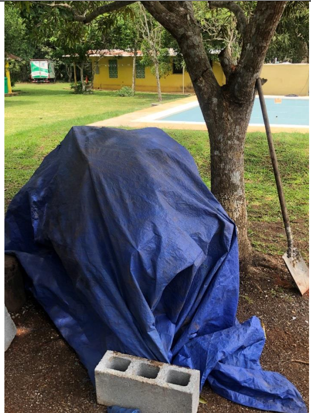
El material no utilizado es cubierto con el fin de mojarse o esparcirse con el viento
