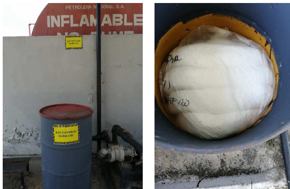
Foto 7-8. Dentro del área se mantiene también un tanque con kit de derrame en caso de incidente.
