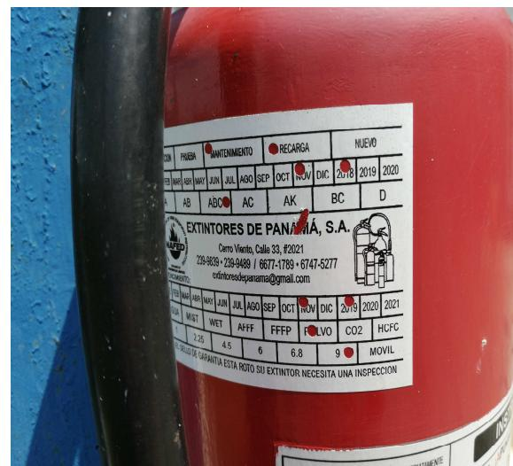
Foto 4-5. Se mantienen dos extintores en el área del proyecto Tipo ABC.
