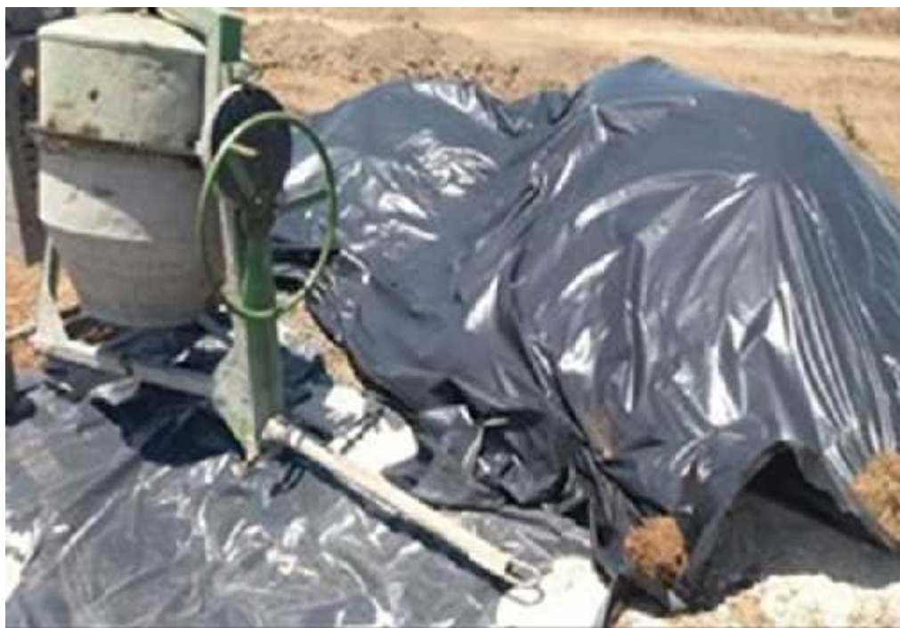
CUBRIMIENTO DE MATERIAL GRANULAS PARA EVITAR SU DISPERSIÓN
