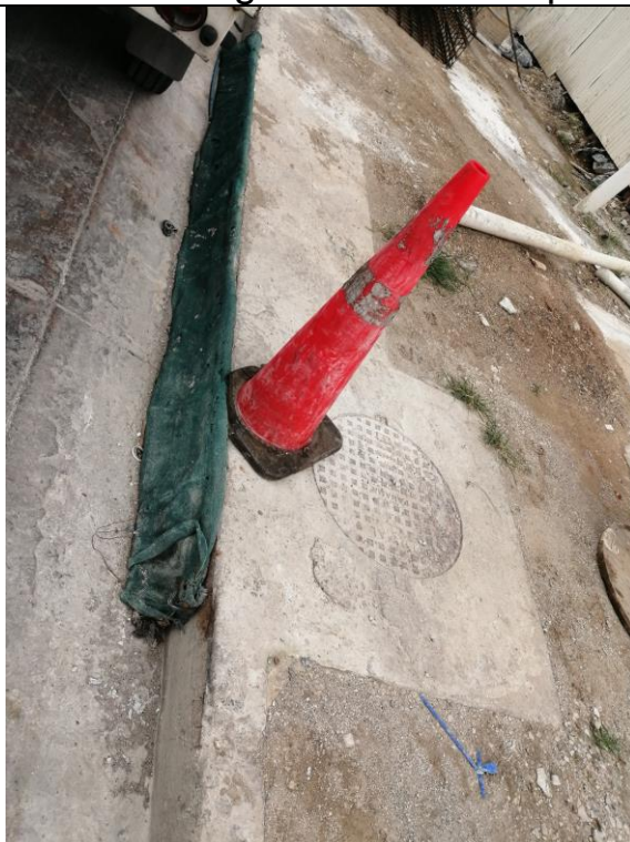
Fotografía No. 3: Se observa drenaje con geo textil para impedir la entrada de sólidos.
