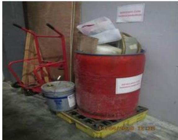
Imágenes 48 a 53. Bandejas de contención utilizadas en el almacén de aceites usados y productos peligrosos y otras áreas de la planta.
