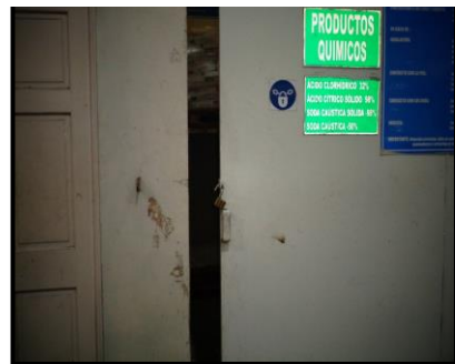
La puerta del área de productos químicos debe permanecer cerrada y con candado cuando no se haga uso de algún producto químico, se pudo evidenciar que el candado se encuentra dañado.
