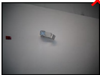
Lámpara de emergencia mal instalada, el botón de prueba esta hacia arriba cuando debe estar hacia abajo.
