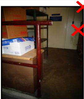
Extremo salido del barandal se encuentra muy cerca del paso de la escalera.
