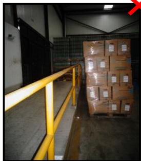
Bases de la baranda de la bodega se encuentran flojas, deterioradas y expuestas.
