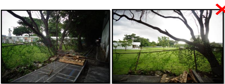
Se evidenció que la cerca perimetral ha cedido y puede ser vulnerada fácilmente por personas ajenas a la empresa. Se deben tomar medidas para prevenir que suceda.
