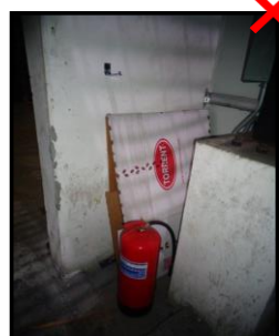
Se observó que el soporte del extintor del cuarto de tapas se encuentra roto y el mismo debe estar en el suelo. Esto debe ser reparado a la brevedad.
