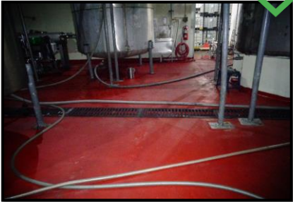
Reparación del piso y del drenaje mantiene el área limpia y evita acumulación de agua.
