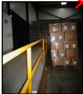
Bases de la baranda de la bodega se encuentran flojas, deterioradas y expuestas.
