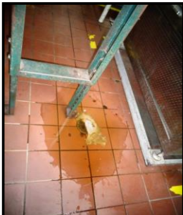
Se observó que el desagüe del área de la encapsuladora de la línea 4 se encuentra tapado.
