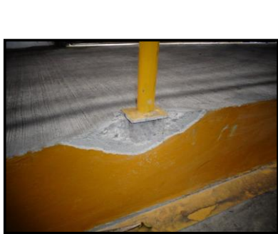
Bases de la baranda de la bodega se encuentran flojas, deterioradas y expuestas.
