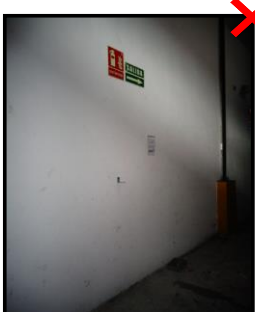
Se evidenció la falta del extintor en la bodega de suministro y reciclado.
