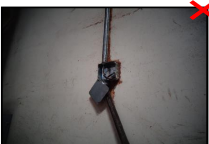
Caja eléctrica abierta sin la debida tapa de protección. La misma se encuentra entrepuerta.
