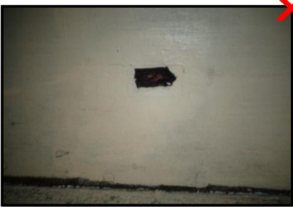
Cables eléctricos sin su debida tapa de protección.
