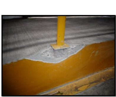
Bases de la baranda de la bodega se encuentran flojas, deterioradas y expuestas.
