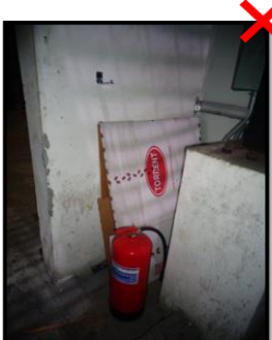
Se observó que el soporte del extintor del cuarto de tapas se encuentra roto y el mismo debe estar en el suelo. Esto debe ser reparado a la brevedad.
