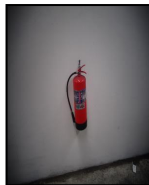
Se evidenció que los extintores de la bodega nueva necesitan mantenimiento. (Observación: Cambiar extintores ya que el proveedor actual no ofrece mantenimiento a esa marca de extintores debido a que no cumplen con especificaciones americanas.
