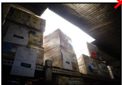
Cajas apiladas justo debajo de las lámparas a una altura muy cercana a las mismas, esta práctica no está permitida por los Bomberos.
