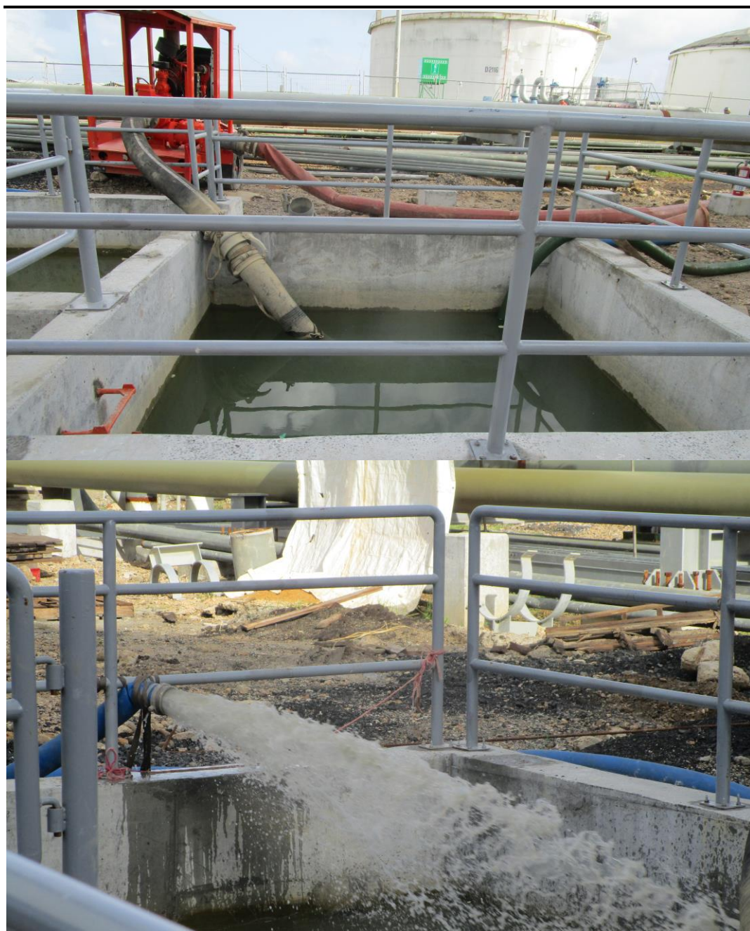
Foto 6 Sistemas de bombeo para extracción de la escorrentía.
