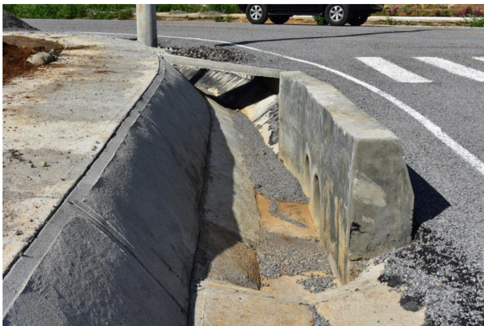
Foto 6 Reforzamiento de taludes para prevenir la erosión Proyecto Residencial Hacienda María
