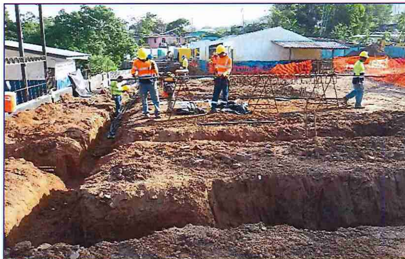
Excavación de Zapatas y Vigas sísmicas del Pabellón #3
