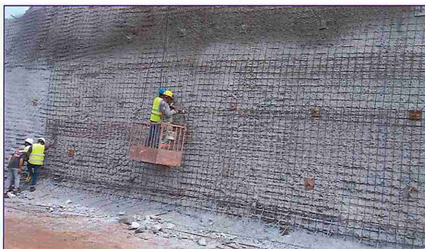
Proceso de Construcción de Muro Atirantado
