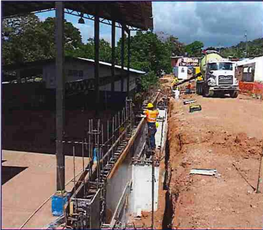
Hormigón en Muro de Cimentación del Pabellón #2
