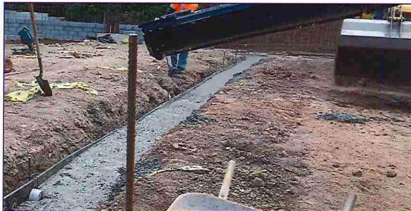
Hormigón en Vigas Sísmicas y Zapatas en el Gimnasio
