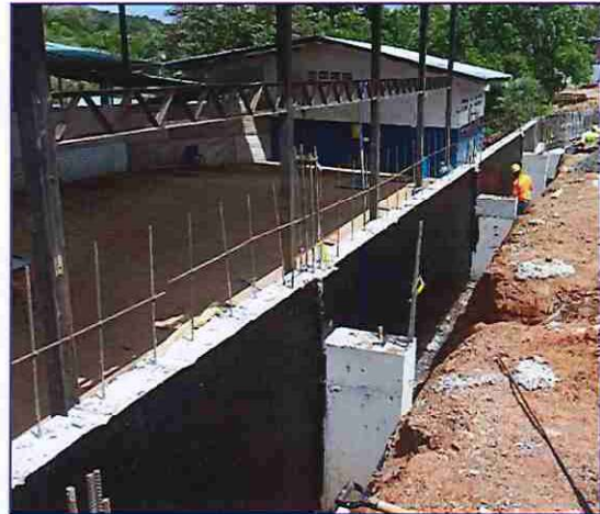
Hormigón en Muro de Cimentación del Pabellón #2
