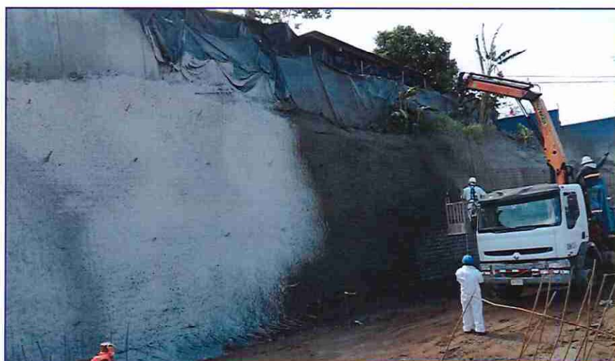
Vaciado de Hormigón de Muro Atirantado
