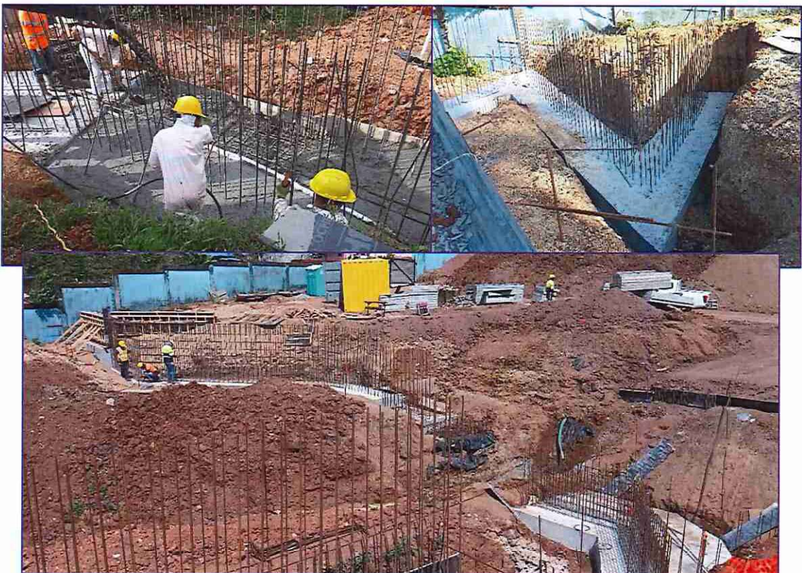
Zapatas de Muro de contención
