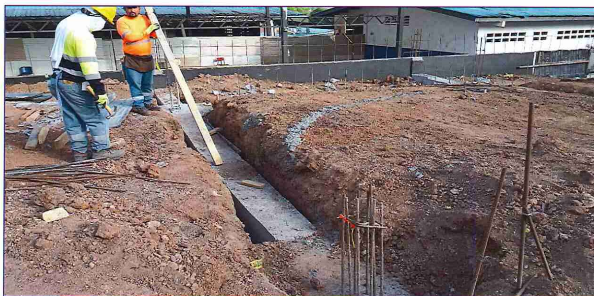
Vaciado de Zapatas y Vigas Sísmicas Pabellón #3
