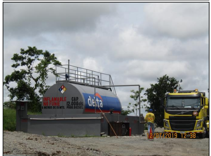
Fotografía N°50-54. Norias de contención
