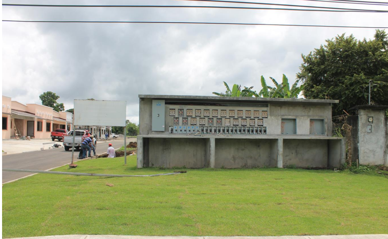
Tapia de medidores y tinqueras
