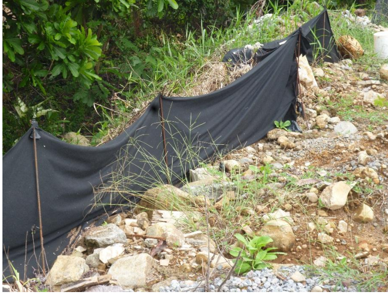
Malla geotextil colocada como medida de control de erosión hacia el drenaje natural pluvial que colinda con el proyecto.
