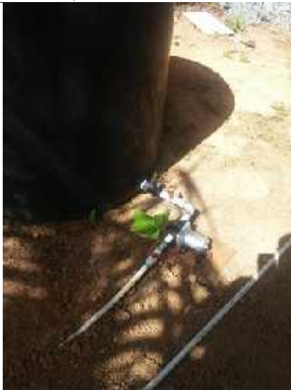
Bomba adosada al tanque que da agua a la ducha.
