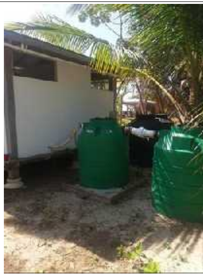
Sistema de tratamiento de aguas residuales
