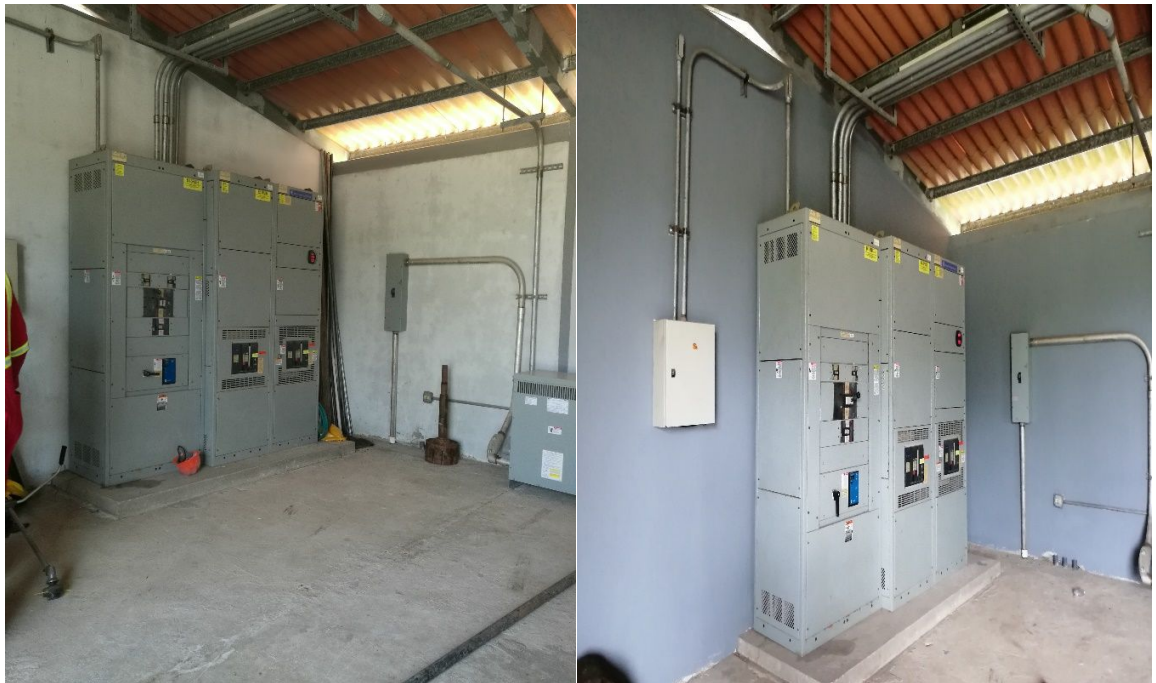
Foto 22-23. Vista del cuarto del Panel eléctrico de la bomba de emergencia (SCI) (antes y después). El mismo ha sido desalojado y remozado.
