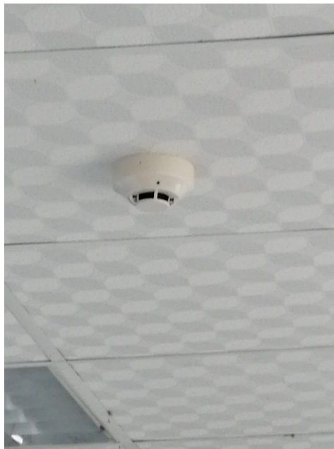
Foto 17. En la caseta de control se mantienen sensores de humos y luces de emergencia.
