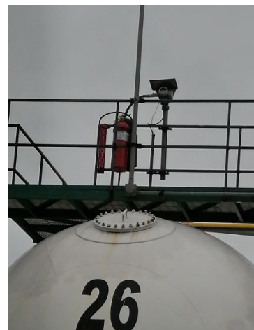
Foto 39-40-41. Se mantienen extintores, sensores y alarmas alrededor de la planta.
