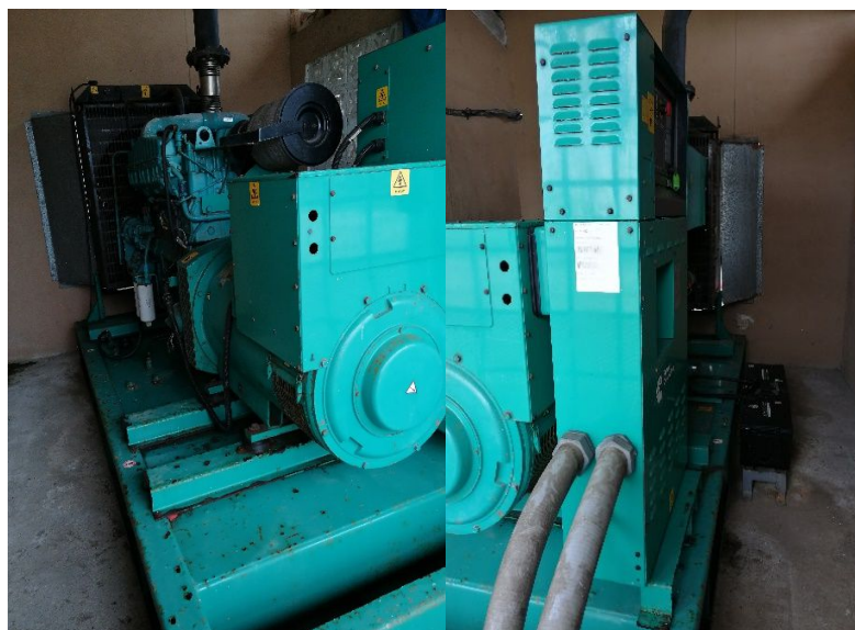
Foto 20-21. Condiciones del generador de emergencia que se ubica en la caseta de control.
