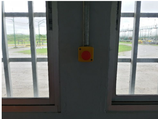
Foto 16. Se mantiene un sistema "shut down" en varias de las estructuras.
