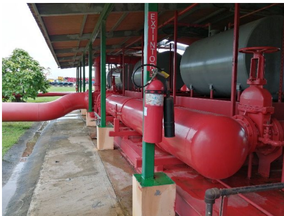
Foto: 3-4-5-6. Instalaciones del Sistema Contra Incendio (SCI), que cubre las instalaciones de Petroport.
