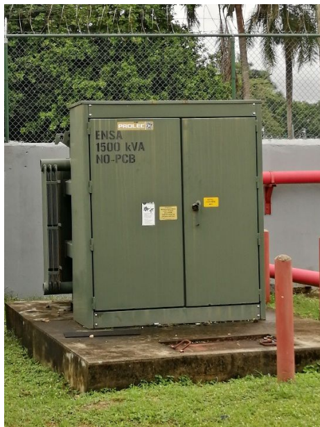
Foto 31-32. La energía eléctrica proviene de la red de ENSA, para lo cual se cuenta con dos transformadores (1500kVA y 750kVA) libre de PCB
