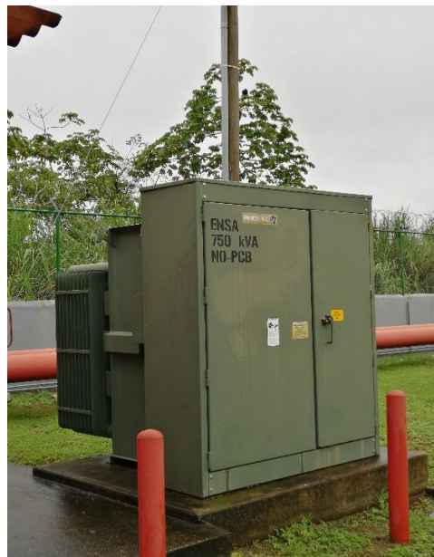
Foto 31-32. La energía eléctrica proviene de la red de ENSA, para lo cual se cuenta con dos transformadores (1500kVA y 750kVA) libre de PCB
