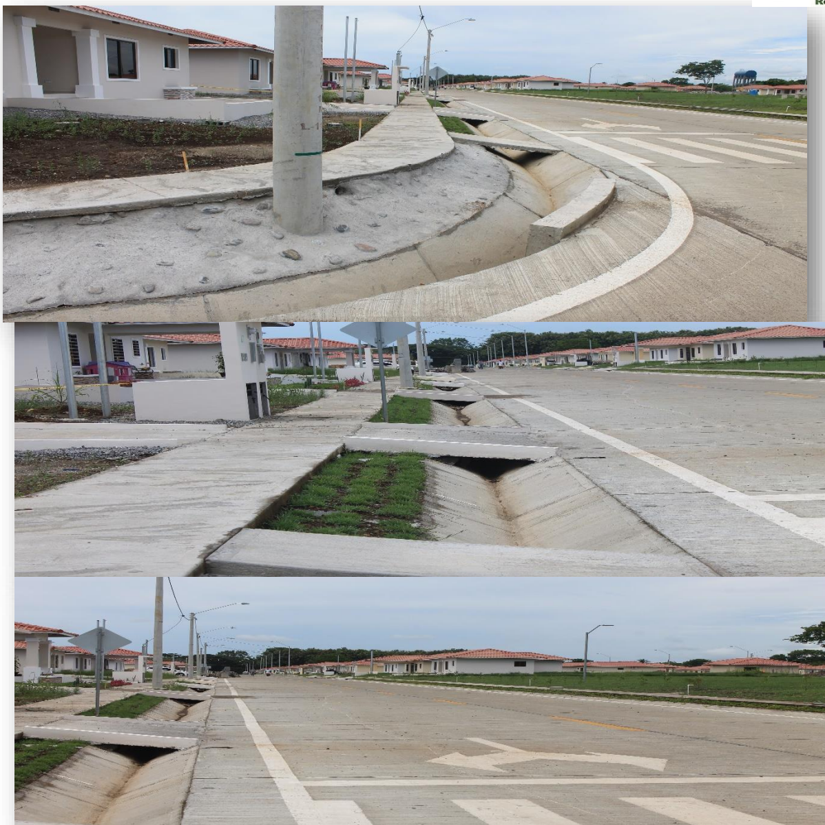
Fotos 10, 11 y 12. Calles y aceras construidas, señalizadas horizontal y vertical. Zampeado en taludes de aceras para evitar la erosión y establecimiento de grama. Agosto 2019. G. Santamaría
