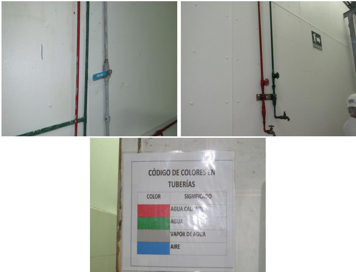
Fotos 16 a 18. Tuberías identificadas por color.
