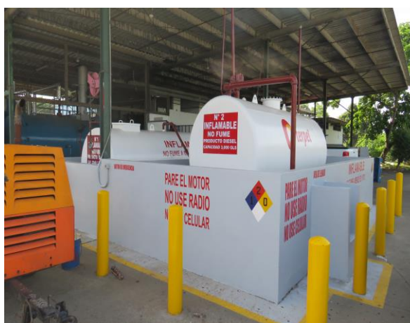
Fotos 8 y 9. Tanque de almacenamiento de combustible con los requerimientos del Cuerpo de Bomberos
