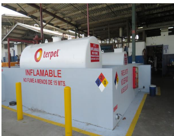
Fotos 8 y 9. Tanque de almacenamiento de combustible con los requerimientos del Cuerpo de Bomberos
