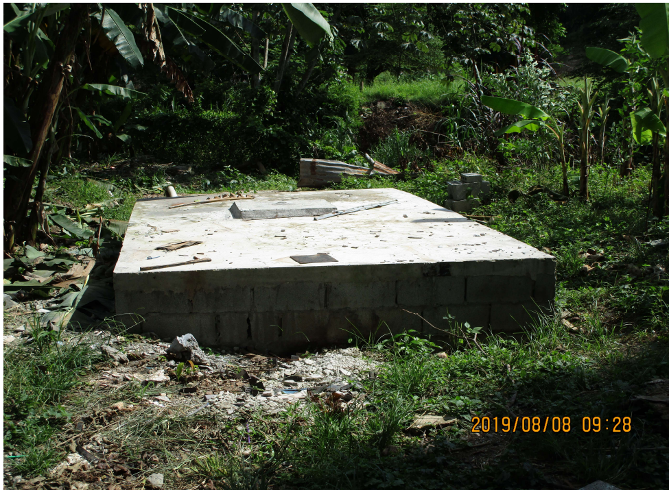
Sistema de tanque séptico construido para manejo de las aguas residuales en el colegio
