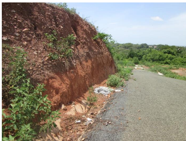
Cunetas sedimentadas.
