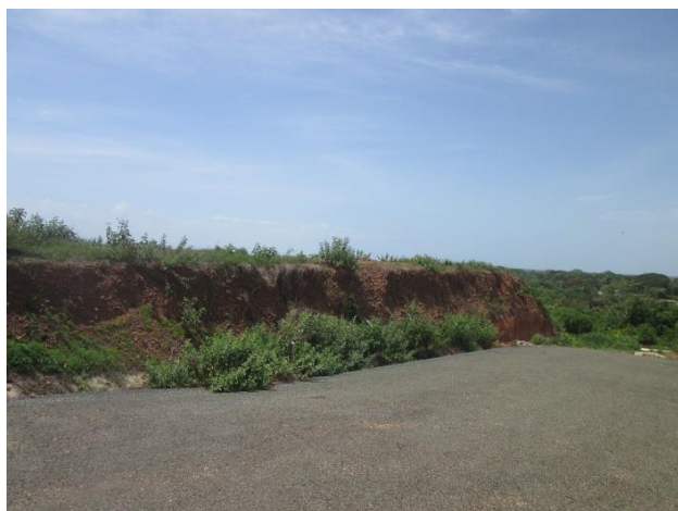
Taludes erosionados, sin protección vegetal.
