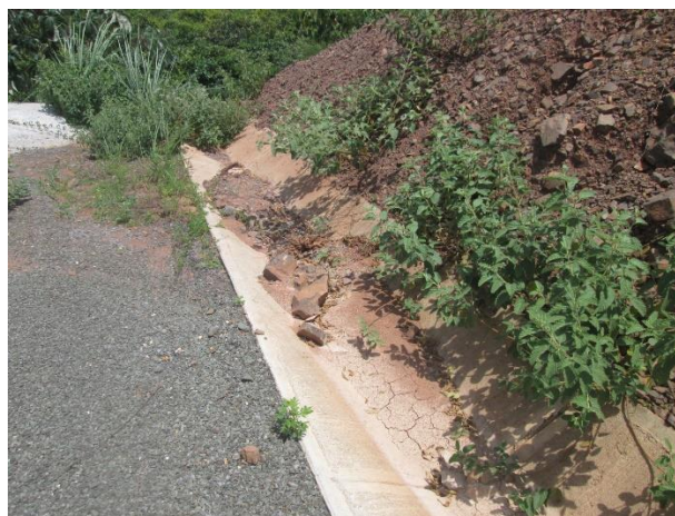
Cunetas sedimentadas.
