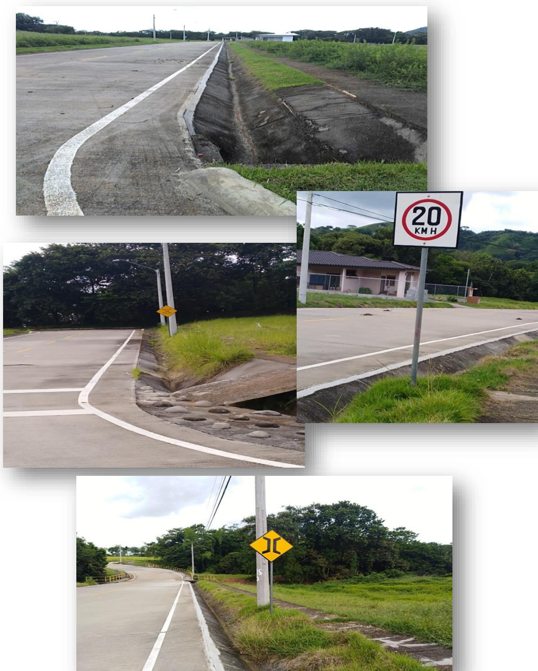
Collage 3. Se muestran las calles de la lotificación terminadas, cunetas abiertas de cemento, zameados en áreas que van hacia los tragantes, señalizaciones horizontales y verticales además aceras con el área verde cubierta de grama. Septiembre 2019. G. Santamaría
