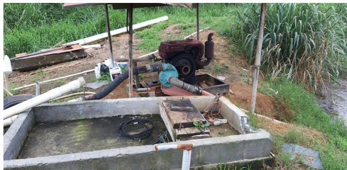
Imagen 6. Se cuenta con la noria construida, por adaptar la bomba de agua y tuberías
