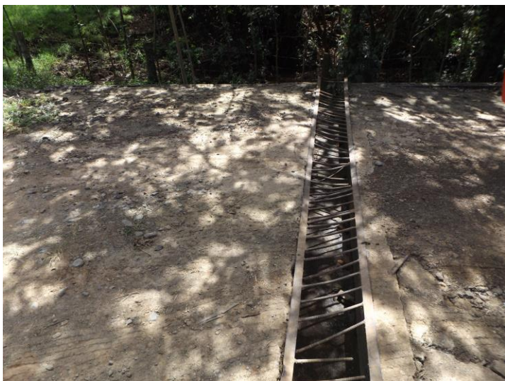
Imagen 19. Sistema de canalización de aguas lluvias de la finca
