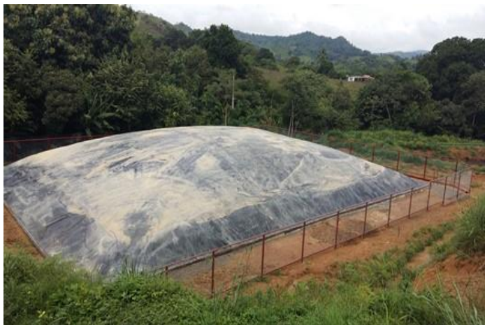
Imagen 5. Biodigestor central de la finca
