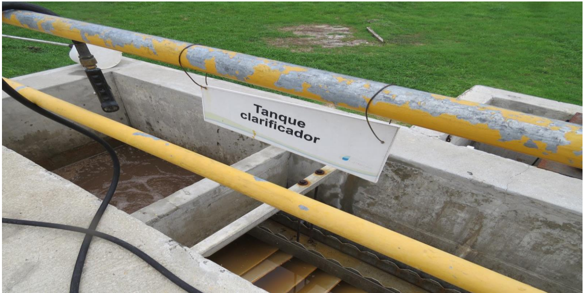
Figura No 10. Tanque clarificador
