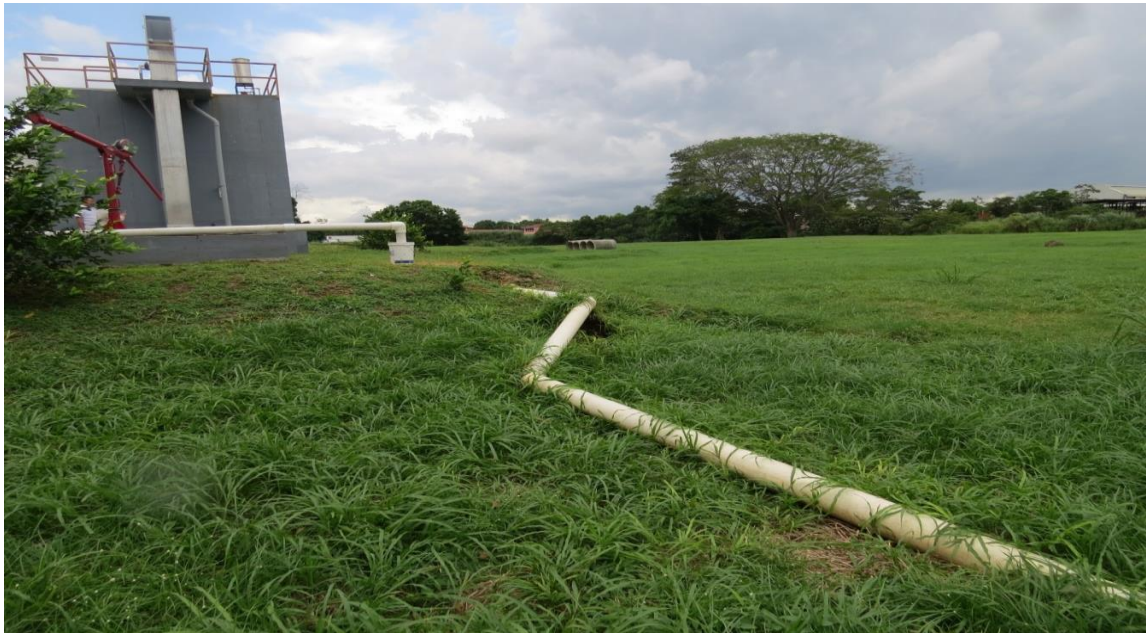
Figura No 12. Tubería de descarga de aguas residuales tratadas en la PTAR
