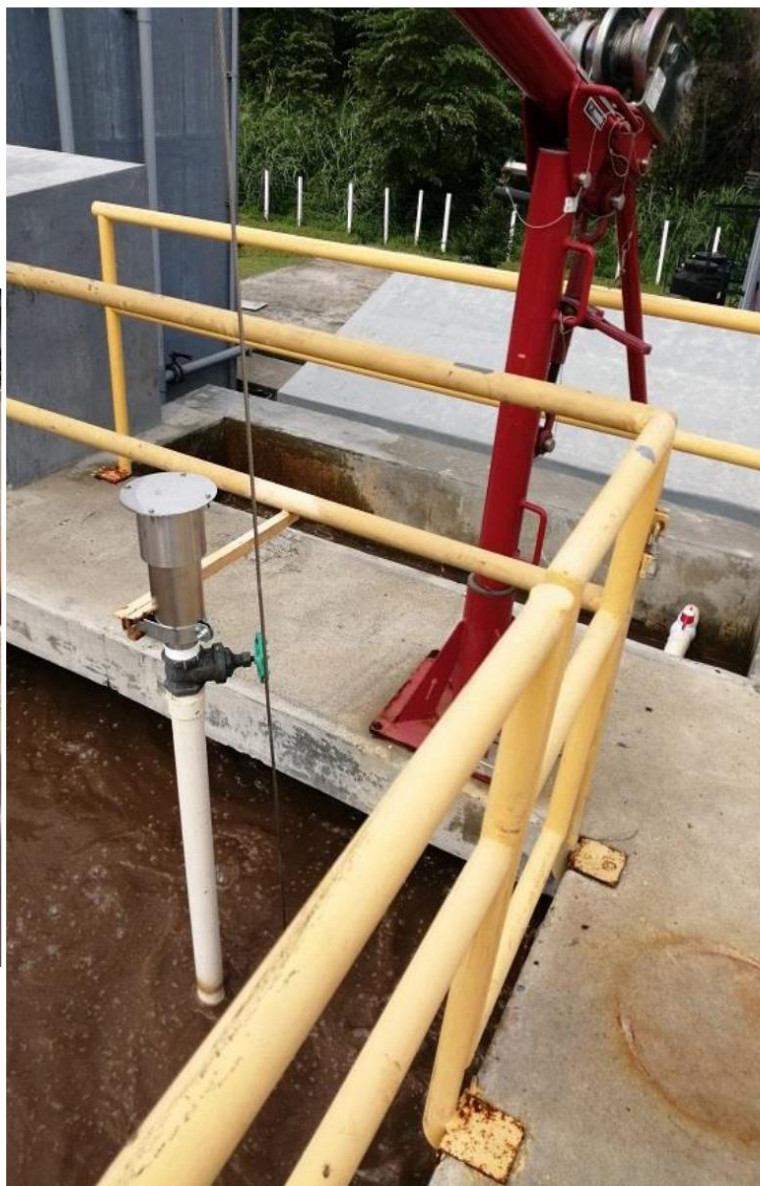
Figura No 20. Acciones de Mantenimiento de la PTAR. Reemplazo de filtro del Aireador No
