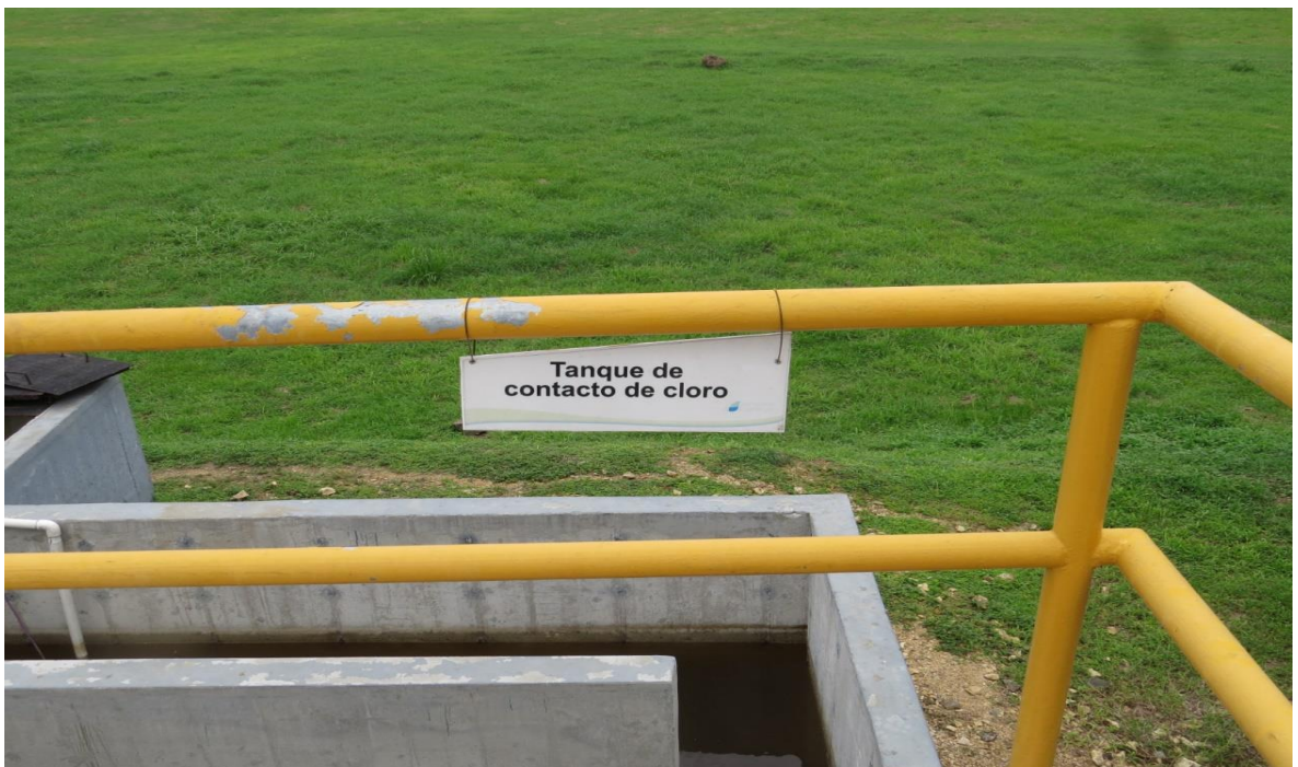
Figura No 11. Tanque de Contacto de cloro
