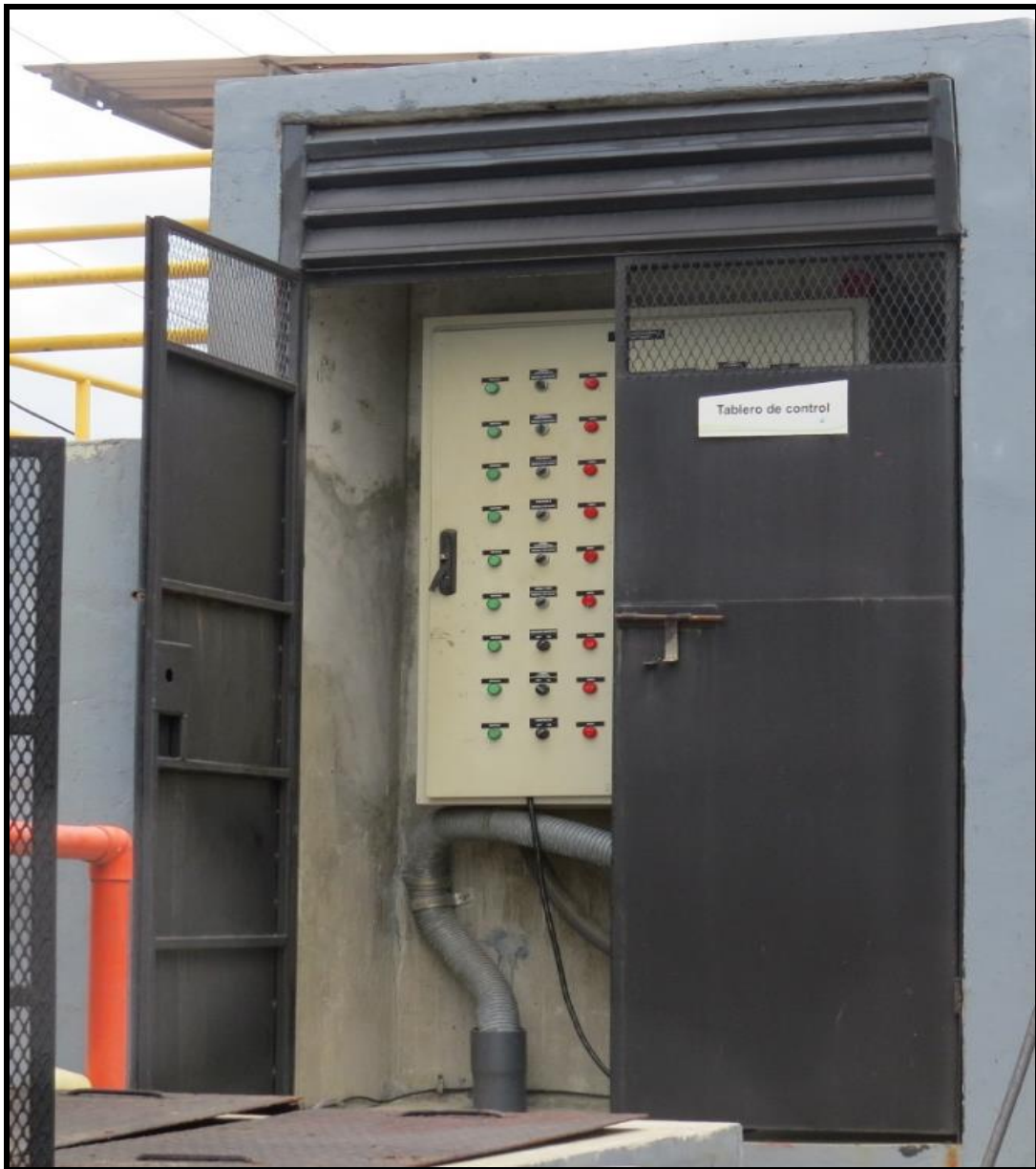
Figura No 16. Sitio de Tablero de Control eléctrico, al cual se le da mantenimiento
