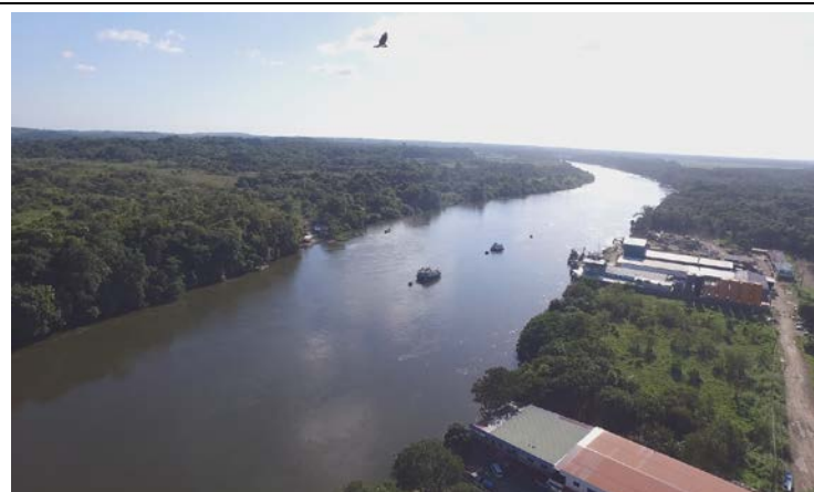
Fig. 12 Vista del Río Bayano, aguas abajo del Puerto de Coquira.
