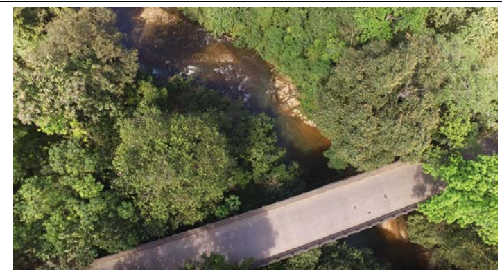
Fig. 22 Vista del puente sobre el Río Cañita en la Vía Interamericana.
