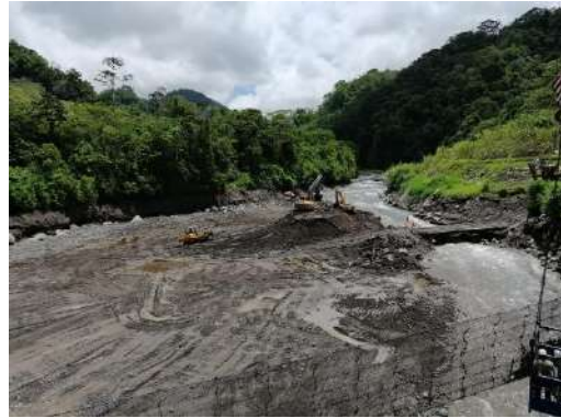
Fig. 17 Carga de material restante en margen izquierda
