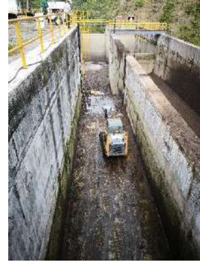
Fig. 12 y 13 Canal de descarga Pando libre de sedimentos
