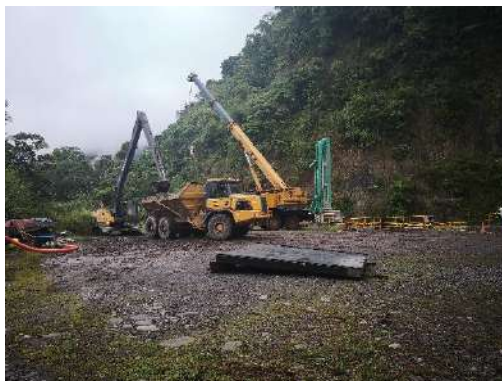
Fig. 10 Carga de sedimentos en camiones articulados
