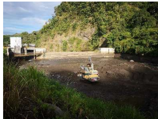
Fig. 6 Movimiento de material en el embalse
