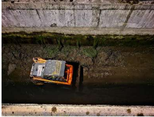
Fig. 12 y 13 Canal de descarga Pando libre de sedimentos
