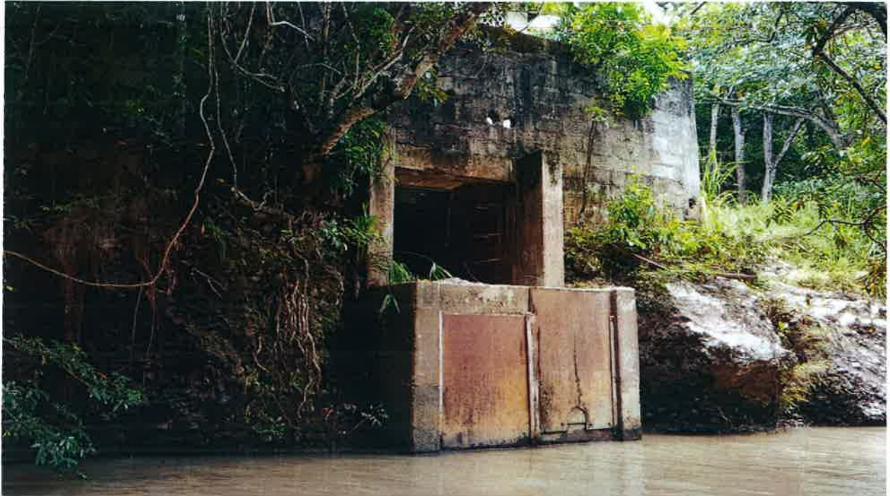
Foto 5-2. Uso del suelo, de la ladera del río Matahogado, Pozo de succión adyacente al río Matahogado, que abastece actualmente la de agua cruda a la Planta de tratamiento de agua potable de San Carlos.
