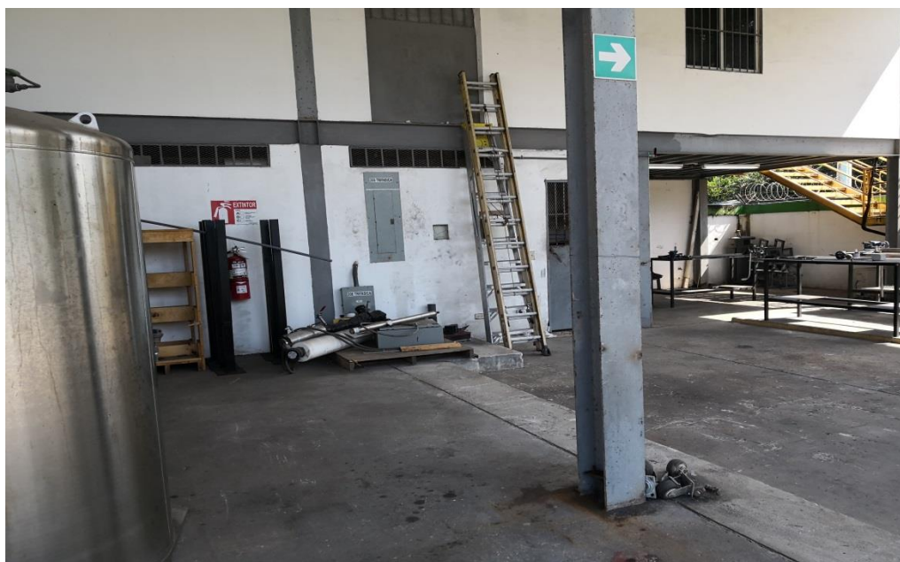
Fotografía No. 2: Extintores ubicados a lo largo de la instalación y señalización de ruta de evacuación.
