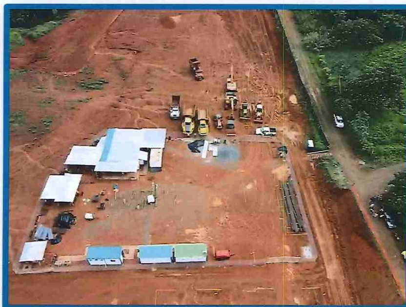
Instalación de campamento con obras temporales (oficinas, depósito, área para manejo de maquinaria)
