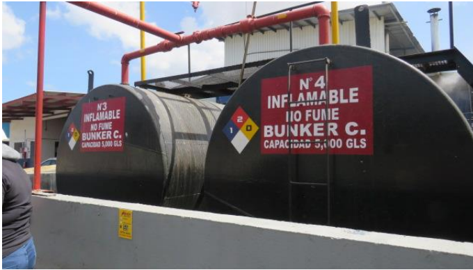
Fotos 7 y 8. Tanque de almacenamiento de combustible
