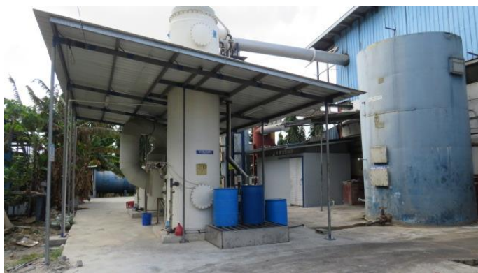
Foto 35. Sistema para control de olores.
