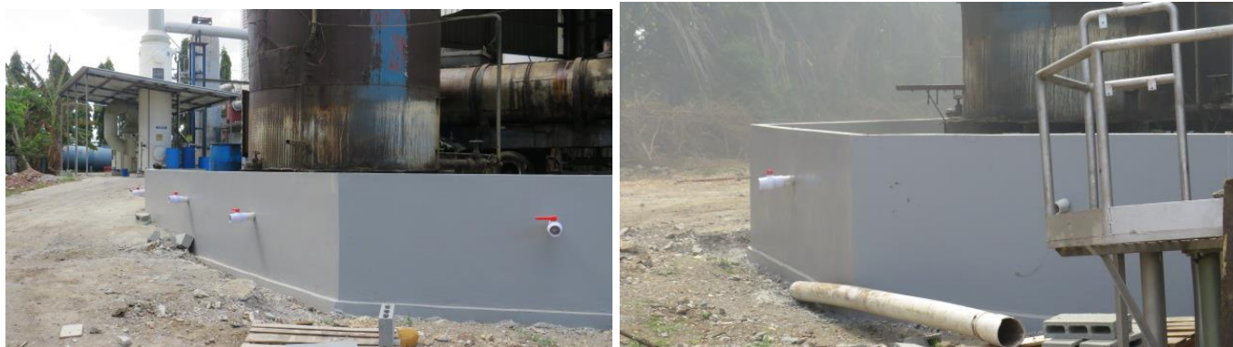
Fotos 1 y 2. Tina de contención construida para el periodo en evaluación.
