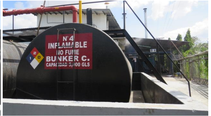
Fotos 7 y 8. Tanque de almacenamiento de combustible
