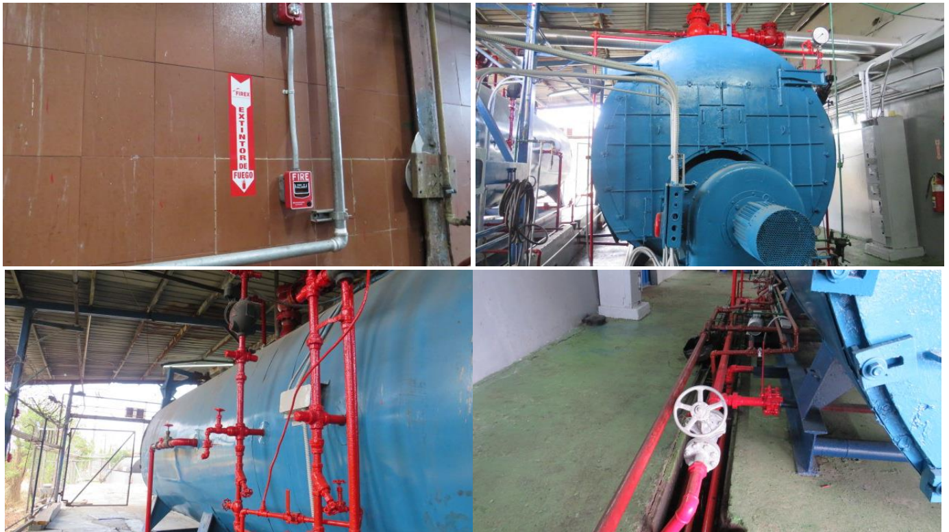
Fotos 25 a 28 Identificación de las tuberías por colores.
