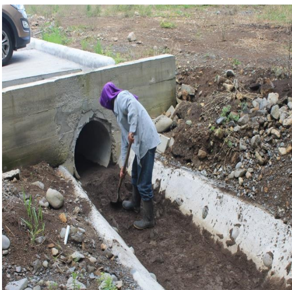
Fotos 3 4. Cunetas libres de sedimentos. Trabajador realizando la labor de limpieza de los drenajes que van hacia la quebrada Lionicia. Foto G. Santamaría 22 de agosto 2019.
