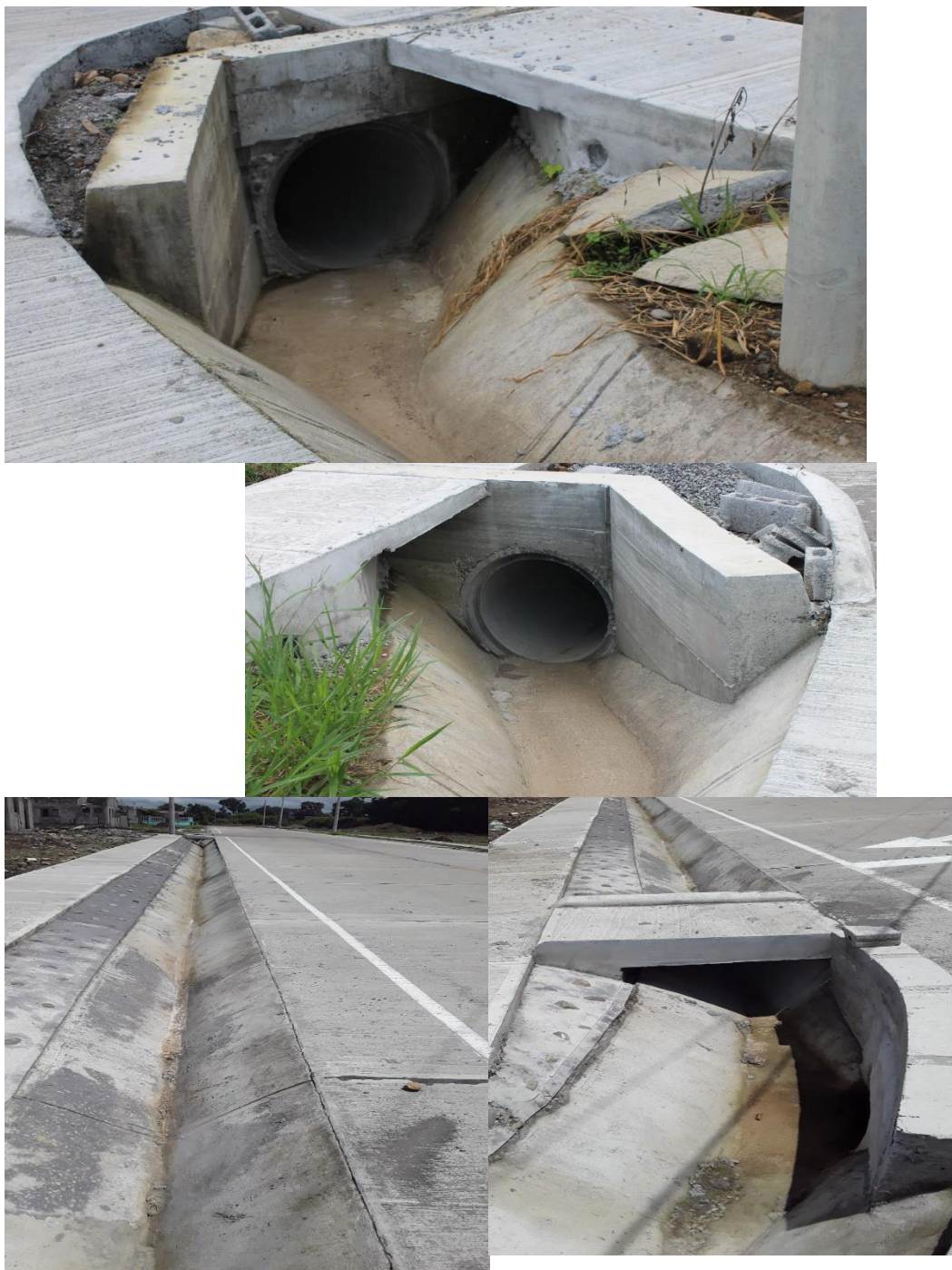
Fotos 5,6,7 y 8. Cunetas, tragantes libres de sedimentos. Zampeado en áreas críticas.
