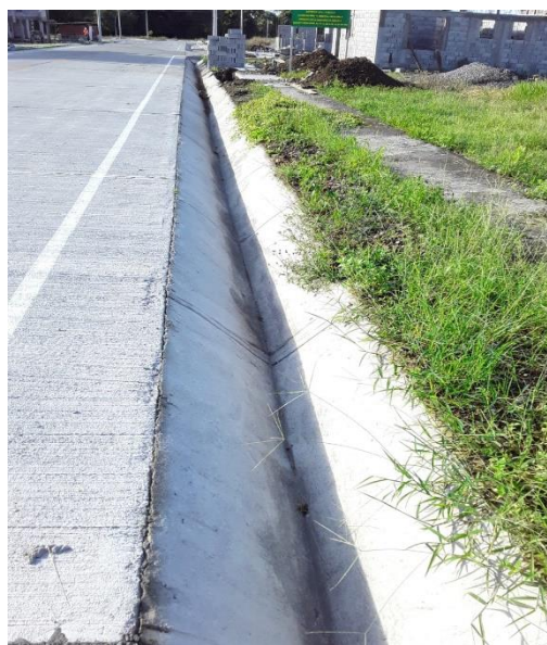
Fotos 3 4. Cunetas libres de sedimentos. Trabajador realizando la labor de limpieza de los drenajes que van hacia la quebrada Lionicia. Foto G. Santamaría 22 de agosto 2019.
