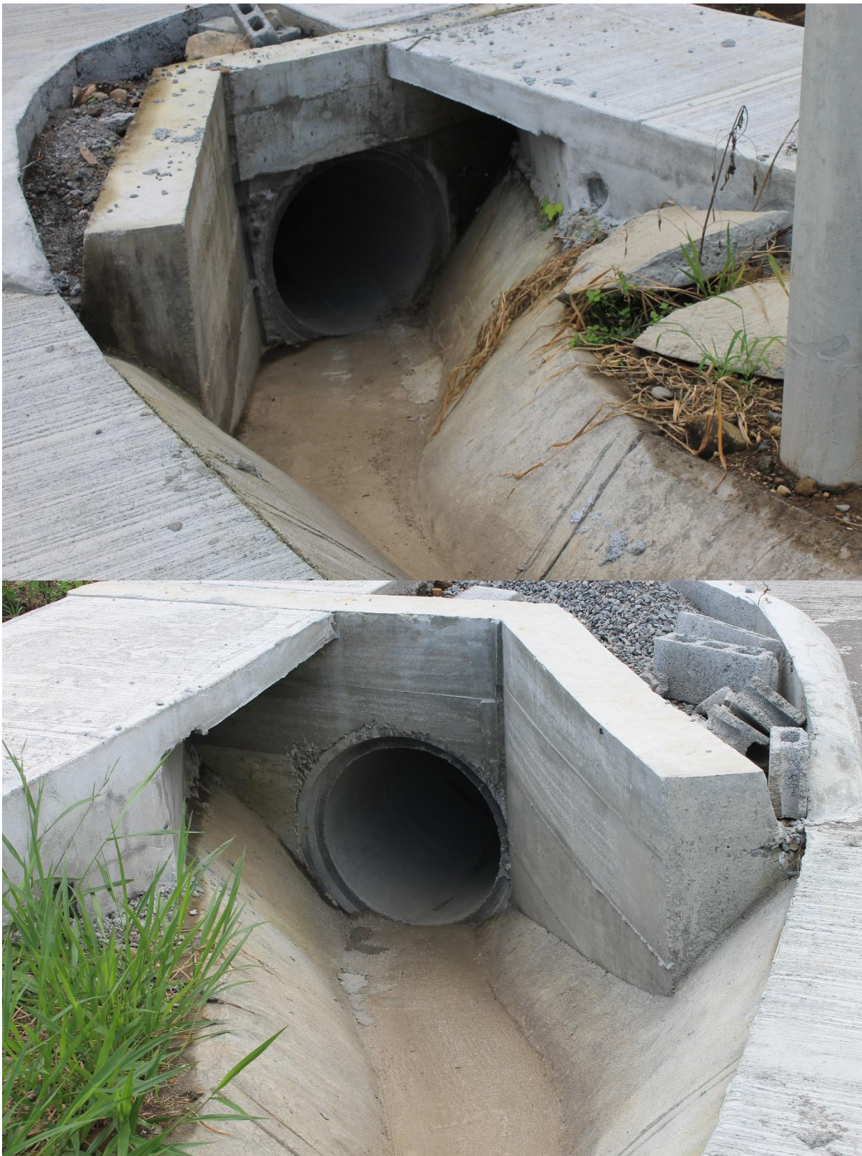
Cunetas, tragantes libres de sedimentos. Zampeado en áreas críticas
