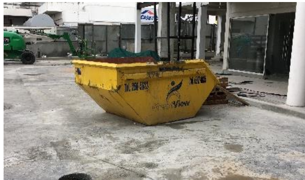
Figura 7. Tanquetas para almacenaje de desechos.
