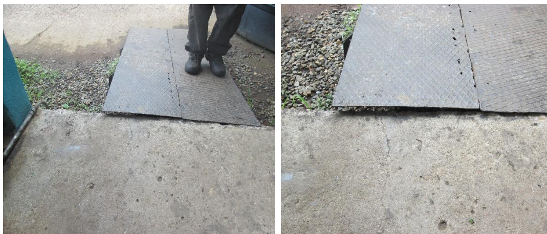
Imágenes 80 y 81. Desnivel sin reparar en el área de ingreso a la planta de tratamiento de aguas residuales y planta de tratamiento de aceites.
