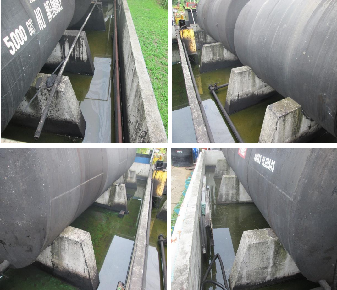
Imágenes 36 a 39. Tinas de contención con agua acumulada.
