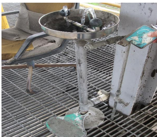
Imagen 27. Lavaojos del área de recepción de materia prima, Pendiente de reparación de pedal.
