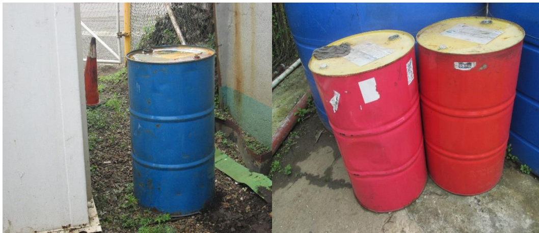
Imágenes 4 a 6. Recipientes con aceites usados, sin bandeja de contención.
