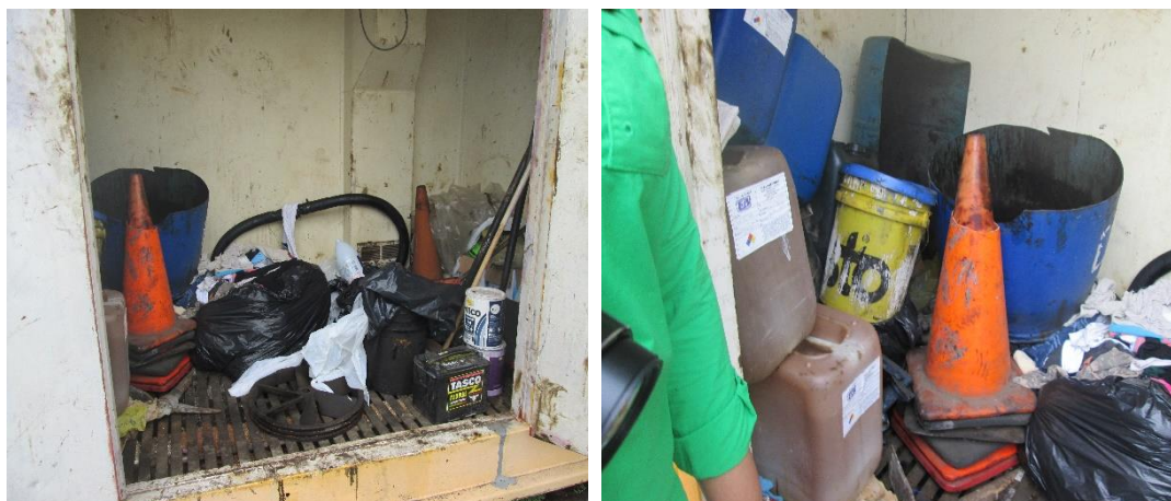
Imágenes 44 y 45. Uso inadecuado de la estación para control de derrames.
