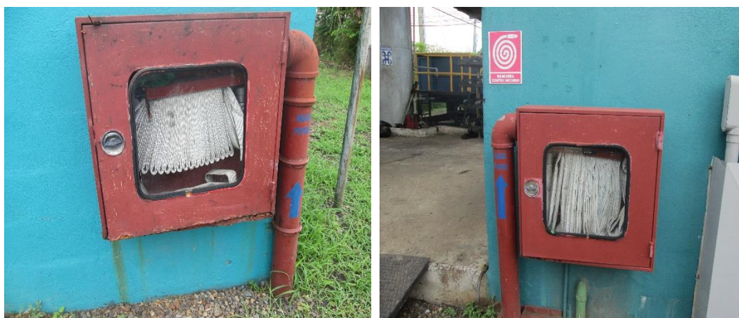
Imágenes 34 y 35. Gabinetes de manguera contra incendio sin la leyenda “para uso en caso de incendio”.
