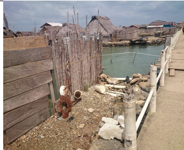
Foto #32. Puente colapsado y relleno con piedras coralinas y gravas del río
