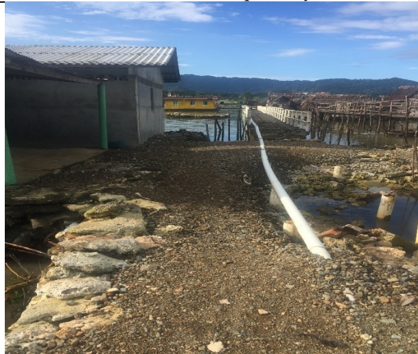
Foto # 31 . Puente colapsado y relleno con piedras coralinas y gravas del río
