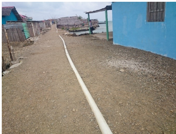
Foto #37. Puente colapsado y relleno con piedras coralinas y gravas del río, observase la tubería de agua potable que va desde el continente hacia la isla Mulatupu
