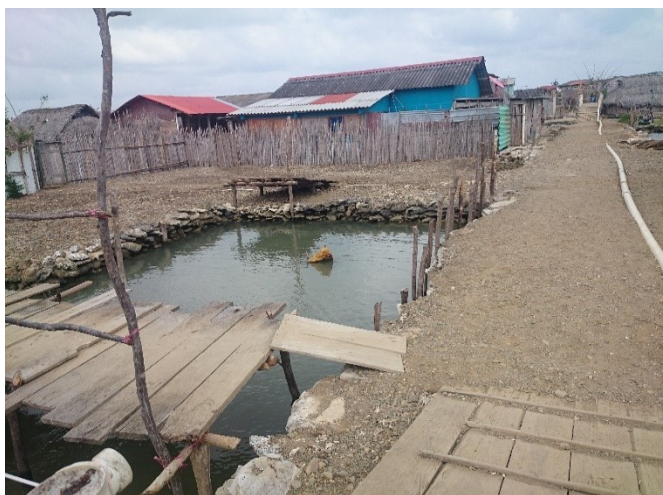
Foto #21. Puente colapsado y relleno con piedras coralinas y gravas del río
