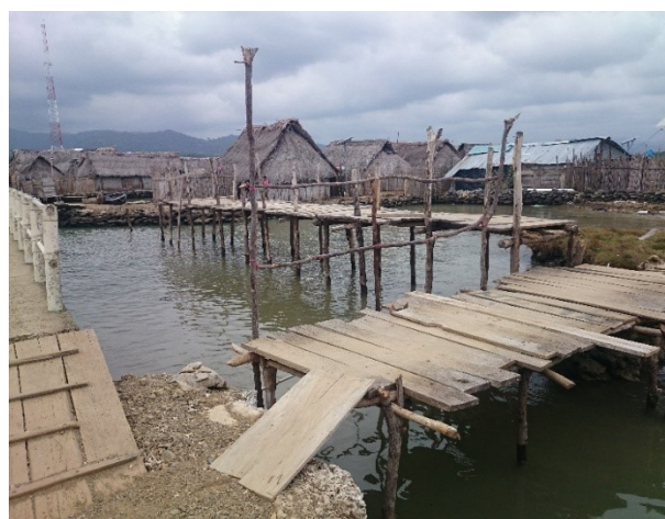
Foto # 30. Pasos de madera y Relleno con piedras coralinas en lados del Puente ,Mulatupu
