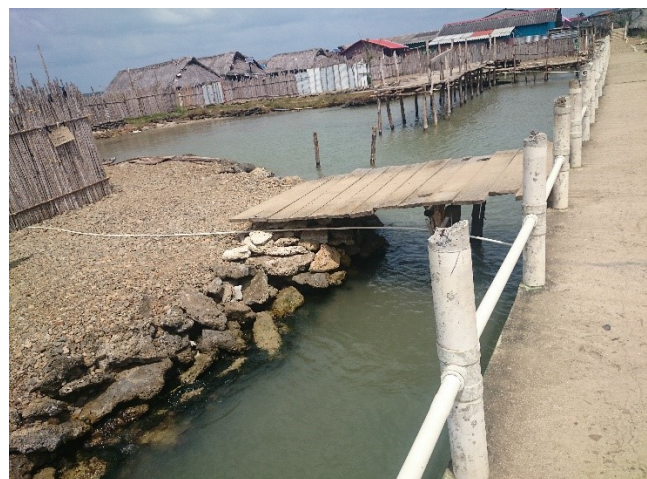
Foto #29. Relleno con piedras coralinas y gravas del río a los lados del Puente entre Mulatupu Isla y tierra firme
