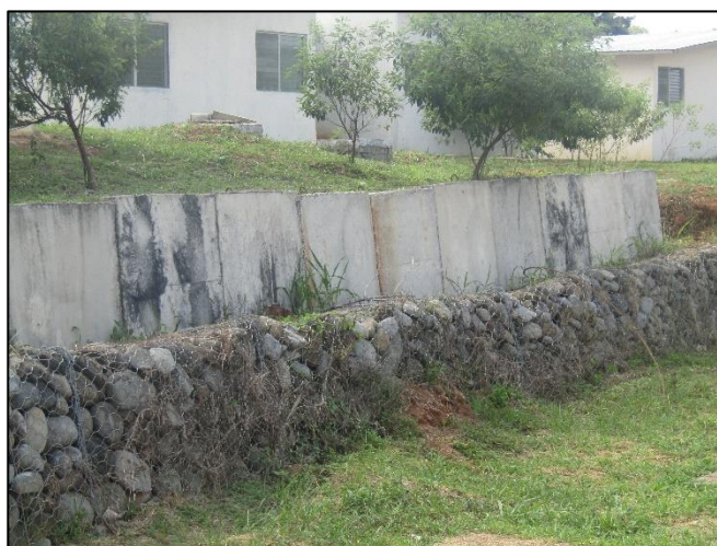
Fotografía N°13-15. Técnicas de control de erosión
