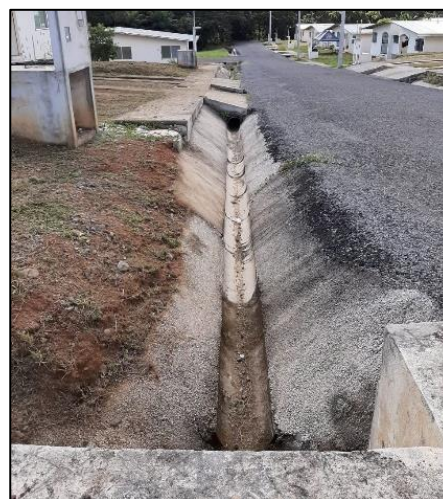
Fotografía N°1-8. Drenajes pluviales del proyecto
