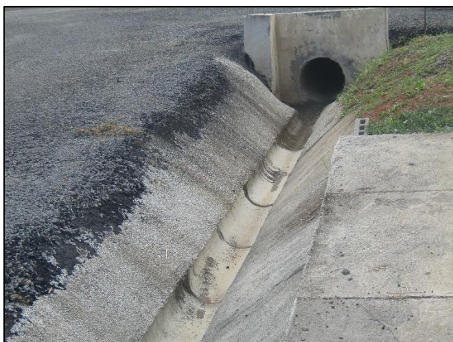
Fotografía N°1-8. Drenajes pluviales del proyecto
