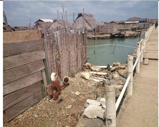
**Foto #32.** Puente colapsado y rellenado con piedras coralinas y gravas del río
