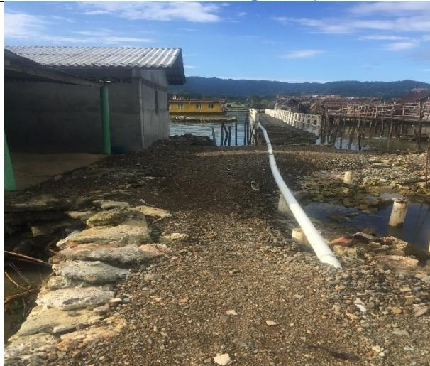
**Foto # 31 .** Puente colapsado y rellenado con piedras coralinas y gravas del río
