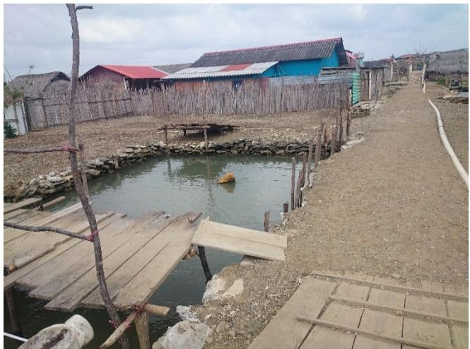
**Foto #21.** Puente colapsado y rellenado con piedras coralinas y gravas del río
