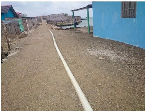
**Foto #37.** Puente colapsado y rellenado con piedras coralinas y gravas del río, observase la tubería de agua potable que va desde el continente hacia la isla Mulatupu
