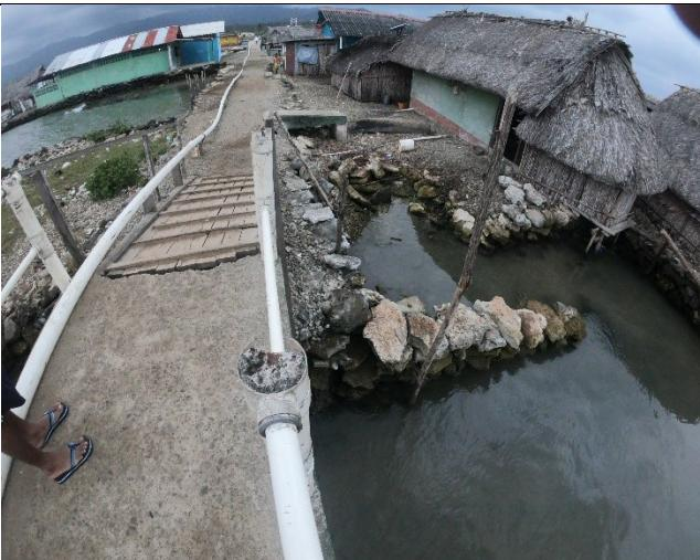
**Foto #55** rellenado con piedras coralinas y gravas del río, observase el color de las aguas de mar estancadas y la tubería de agua potable que va desde el continente hacia la isla Mulatupu
