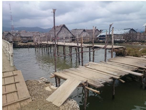
**Foto # 30.** Pasos de madera y Relleno con piedras coralinas en lados del Puente ,Mulatupu
